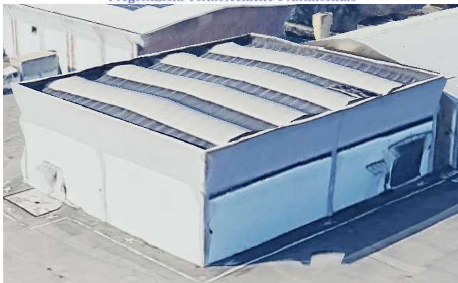
Figura 2: Vista da Nord del fabbricato
