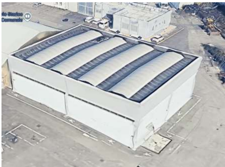
Figura 1: Vista da sud del fabbricato
