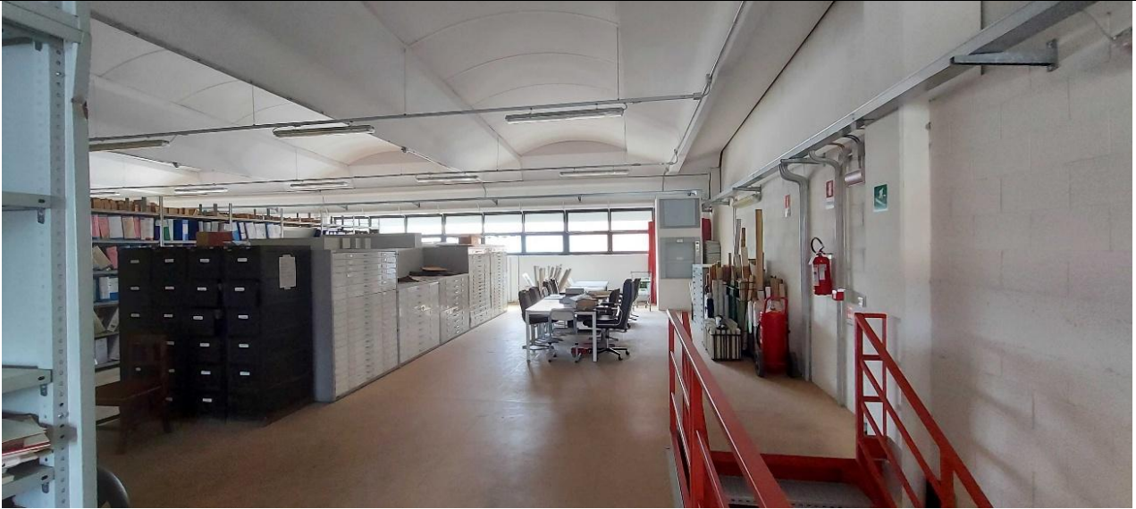
Figura 4 – Vista interna della parete del lato sud al piano primo
