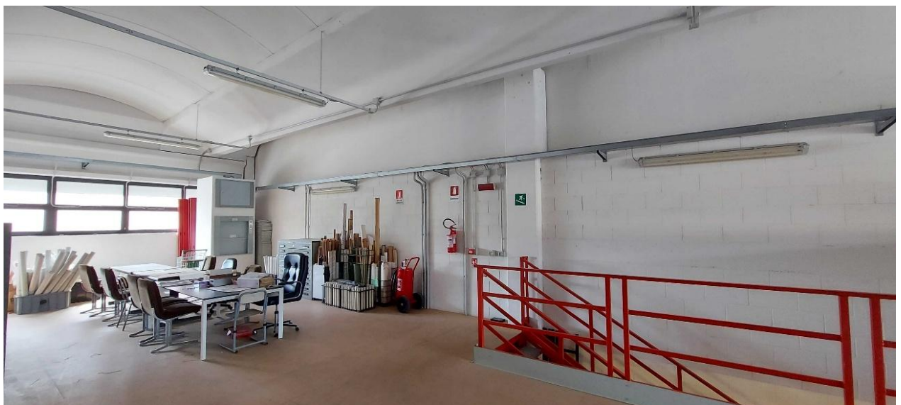
Figura 5 – Vista interna della parete del lato ovest oggetto di installazione del canale e dei diffusori aeraulici
