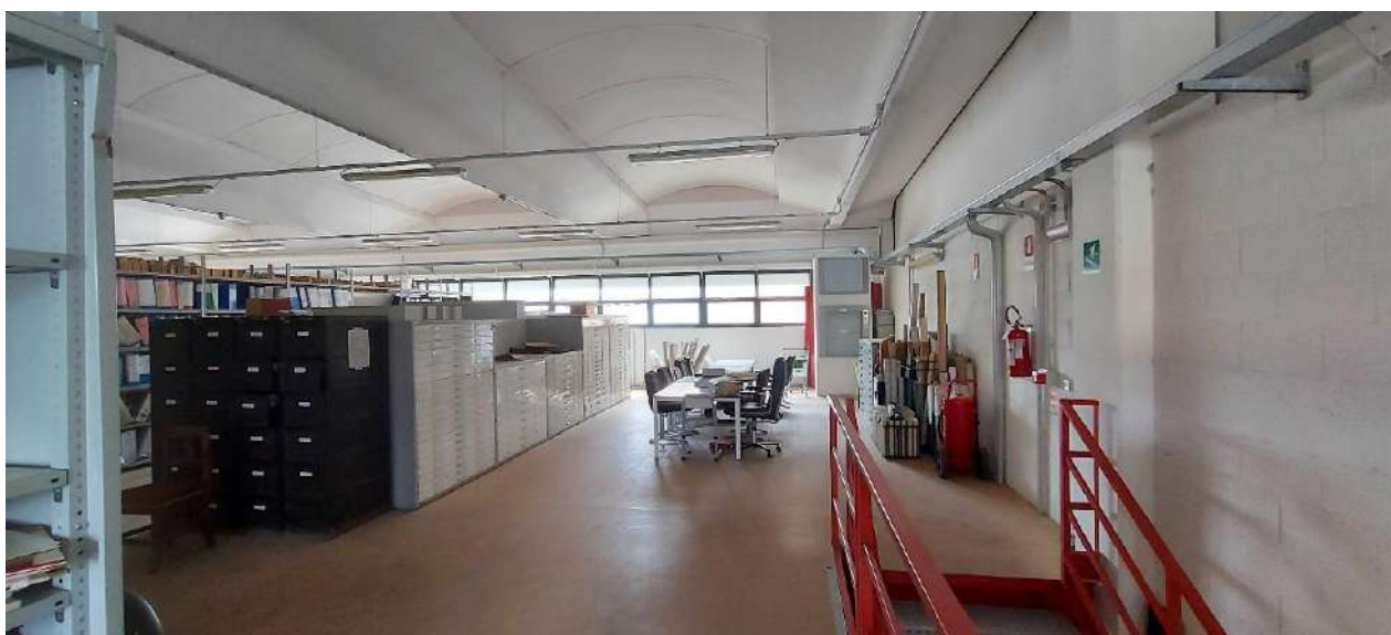
Figura 8 – Vista interna della parete del lato sud al piano primo
