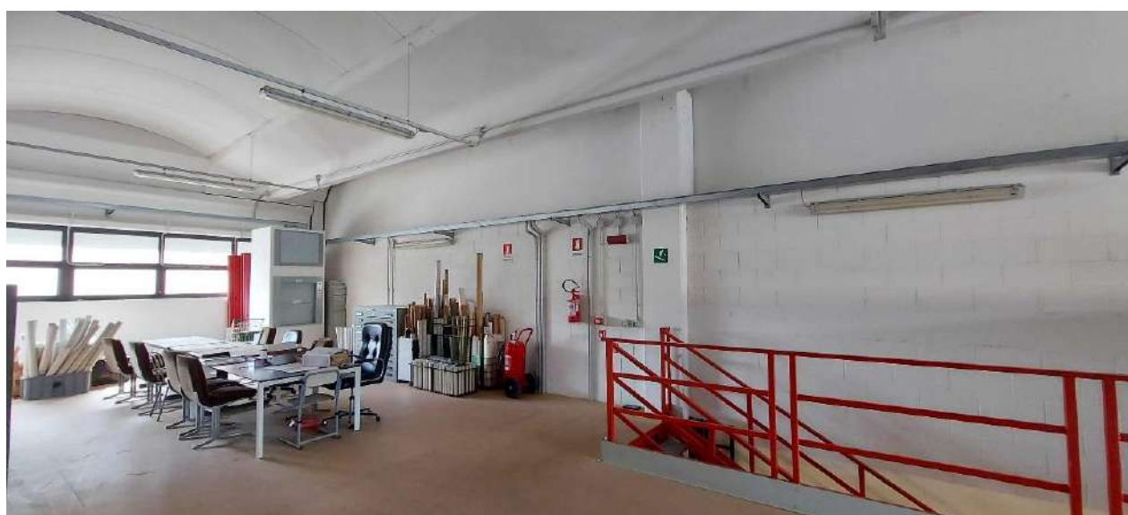
Figura 9 – Vista interna della parete del lato ovest oggetto di installazione del canale e dei diffusori aeraulici
