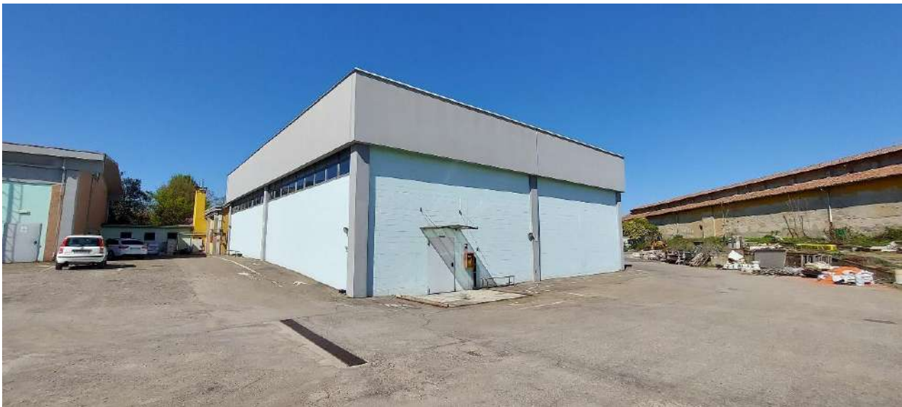
Figura 11 – Vista dei prospetti sud ed est dell'edificio
