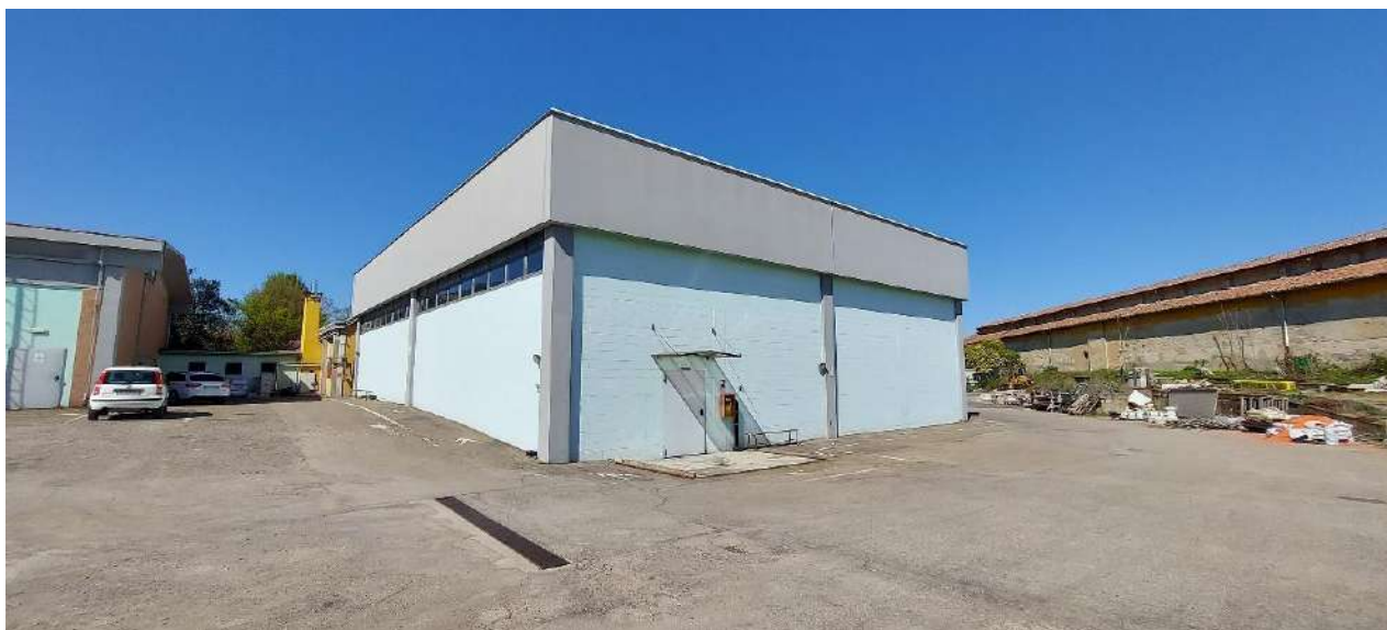
Figura 6 – Vista dei prospetti sud ed est dell'edificio
