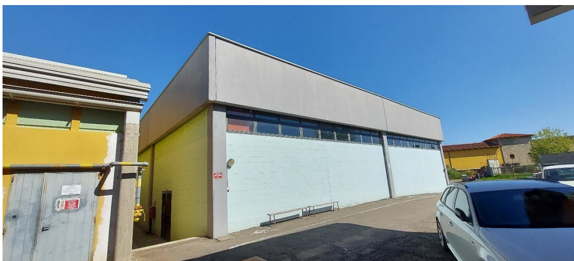
Figura 3: Prospetto sud dove verrà installato il rooftop
