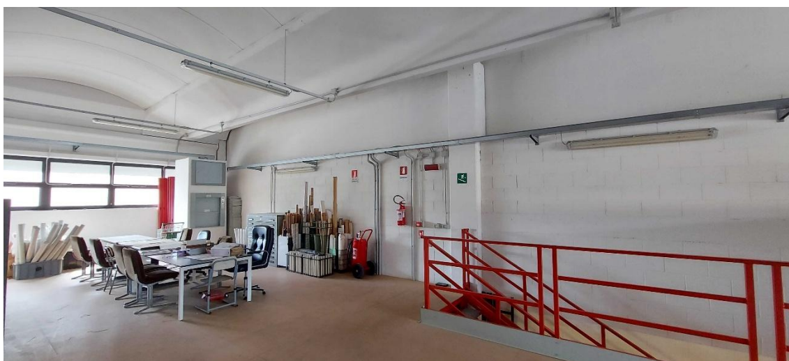
Figura 5: parete lato ovest oggetto di installazione canale e diffusori aeraulici
