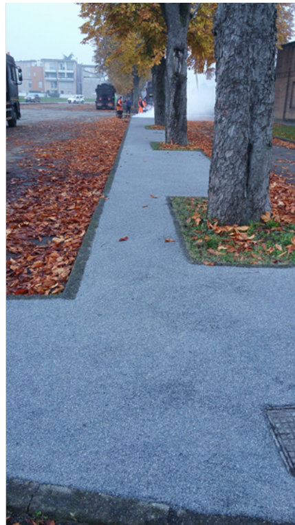
Esempio di intervento su marciapiedi con asfalto colato
