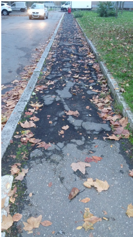
Esempio di intervento su marciapiedi con asfalto colato
