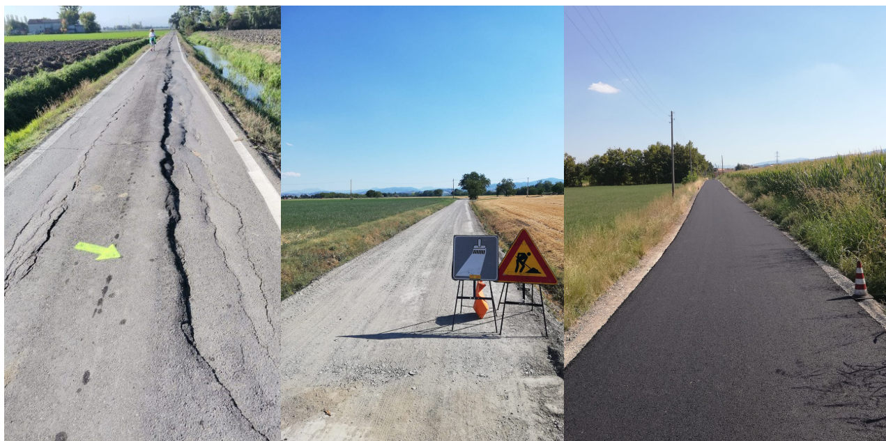
Le tre fasi del processo di lavorazioni: studio, stabilizzazione, finitura
