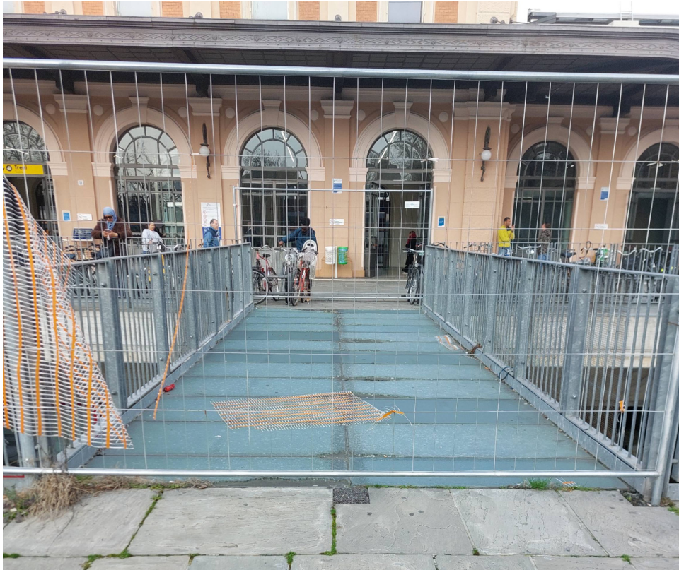
Figure 2 : attuale piano di calpestio
