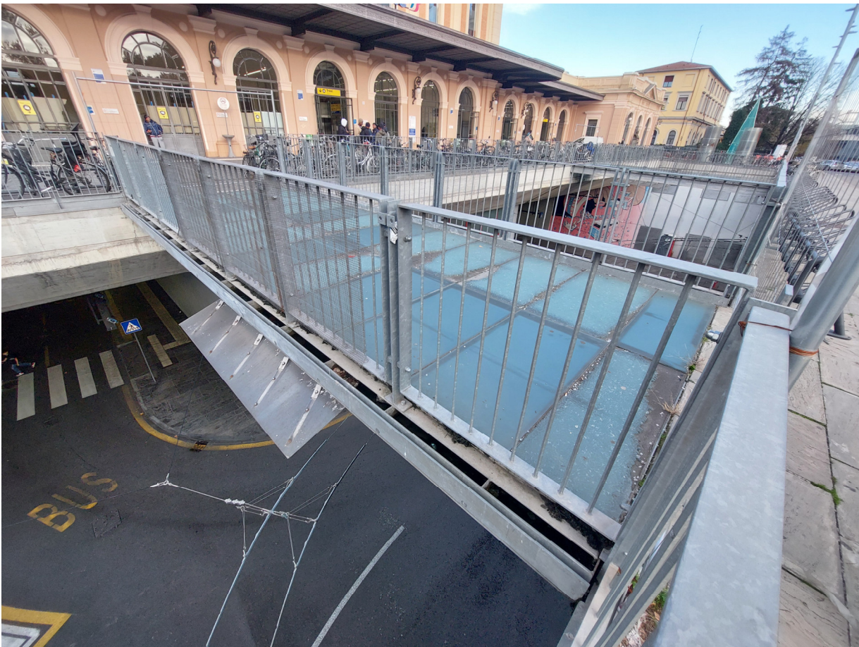
Figure 3 : attuale piano di calpestio
