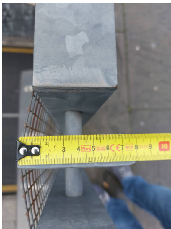
Figura 2 : sezione del montante rilevata 80x10 mm
