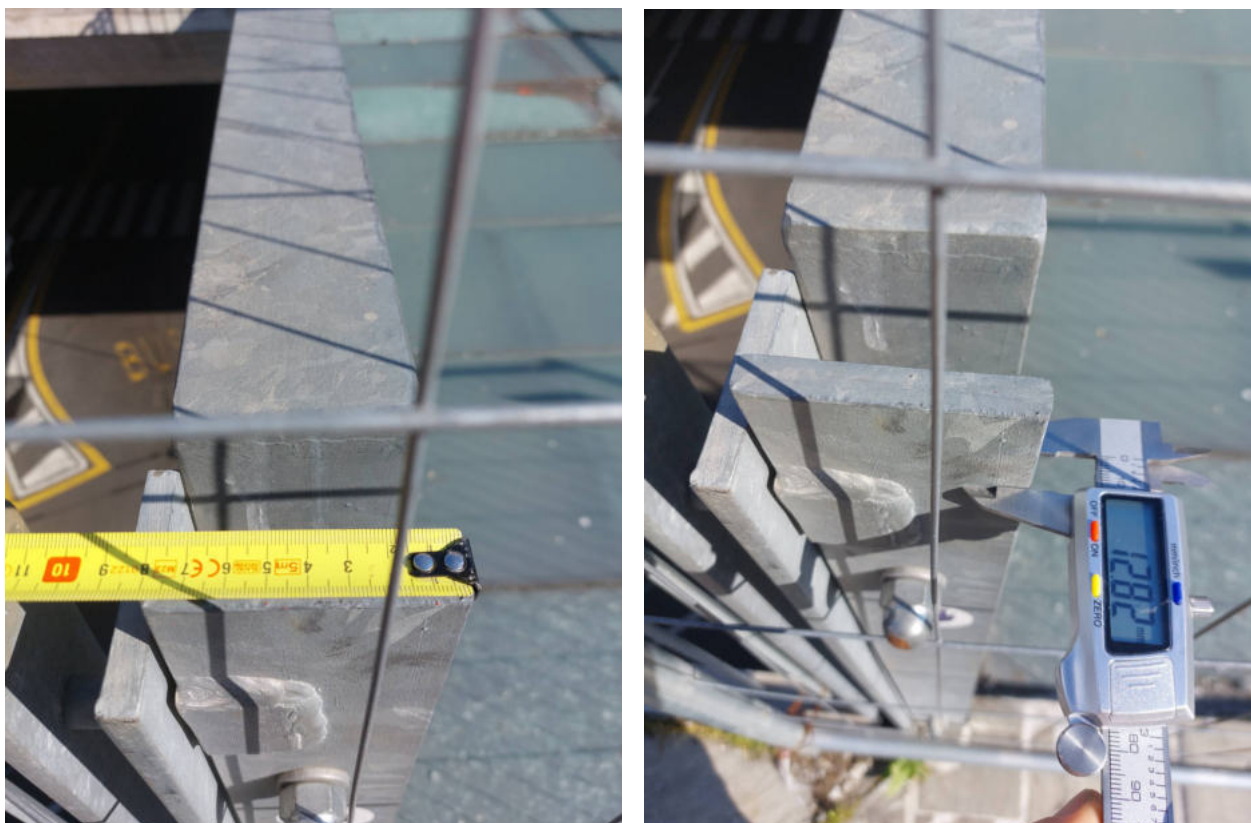
Figura 15: montante del parapetto delle passerelle metalliche
