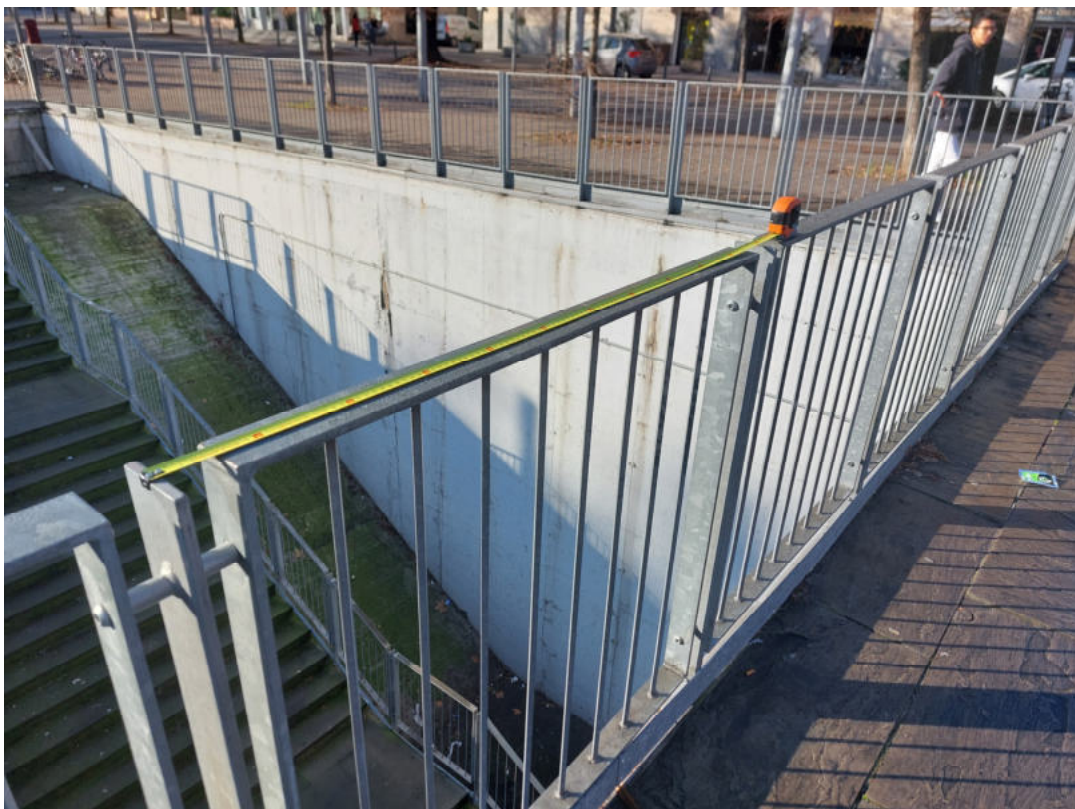
Figura 3 : interasse tra i montanti
