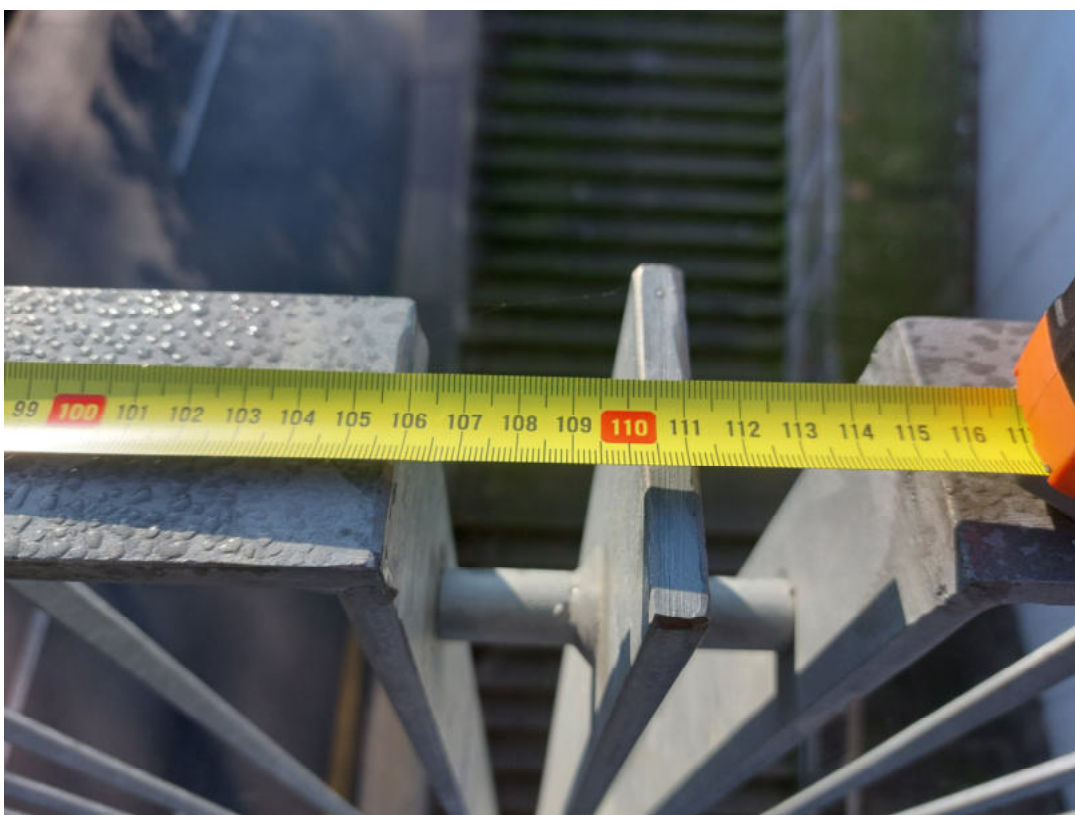
Figura 4 : interasse tra i montanti
