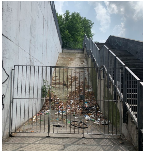
Immagini 7-8: asole predisposte per scale mobili mai installate.
