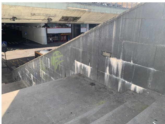
Immagini 3-4: Rivestimento in pietra incollato in stato di degrado
