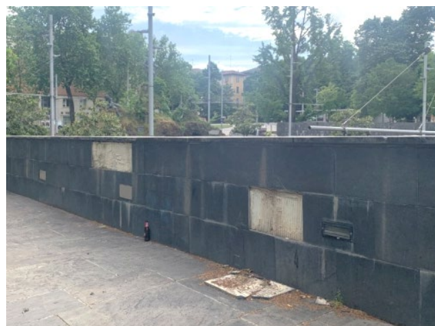
Immagini 3-4: Rivestimento in pietra incollato in stato di degrado
