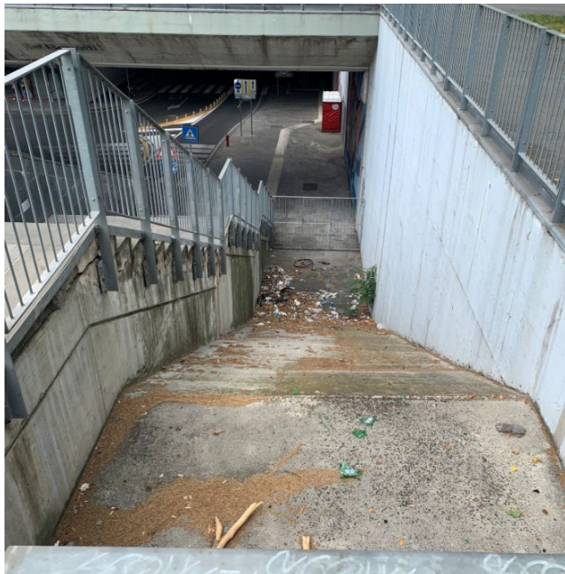
Immagini 7-8: asole predisposte per scale mobili mai installate.
