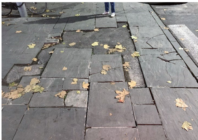
Immagini 1-2: Pavimentazione degradata in lastre di quarzo-arenaria grigia
