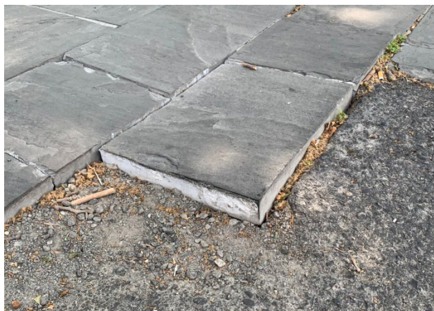
Immagini 1-2: Pavimentazione degradata in lastre di quarzo-arenaria grigia
