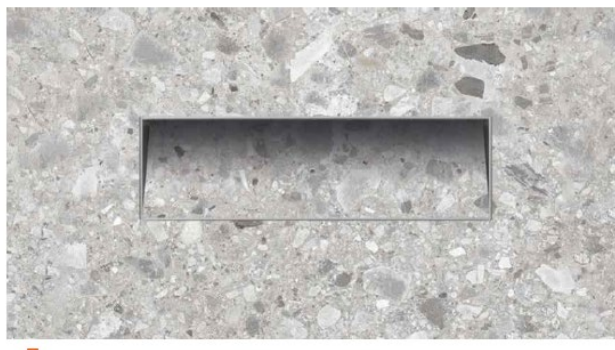
Immagine 47: Nuovi incassi con lampada recessa anti vandalismo tipo SIMES GHOST L430
