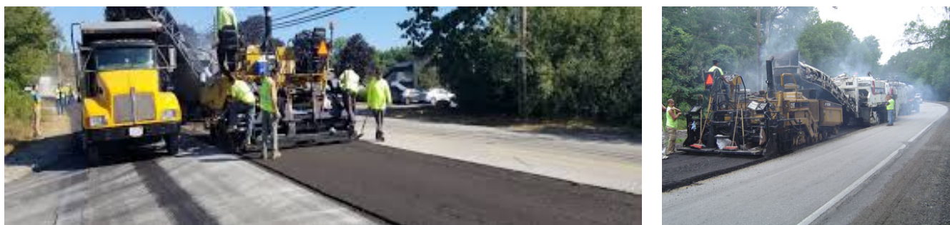
Figura 5-1. Lavorazione a) temperature ridotte "warm" b) lavorazione standard T > 160^{\circ}\text{C}
