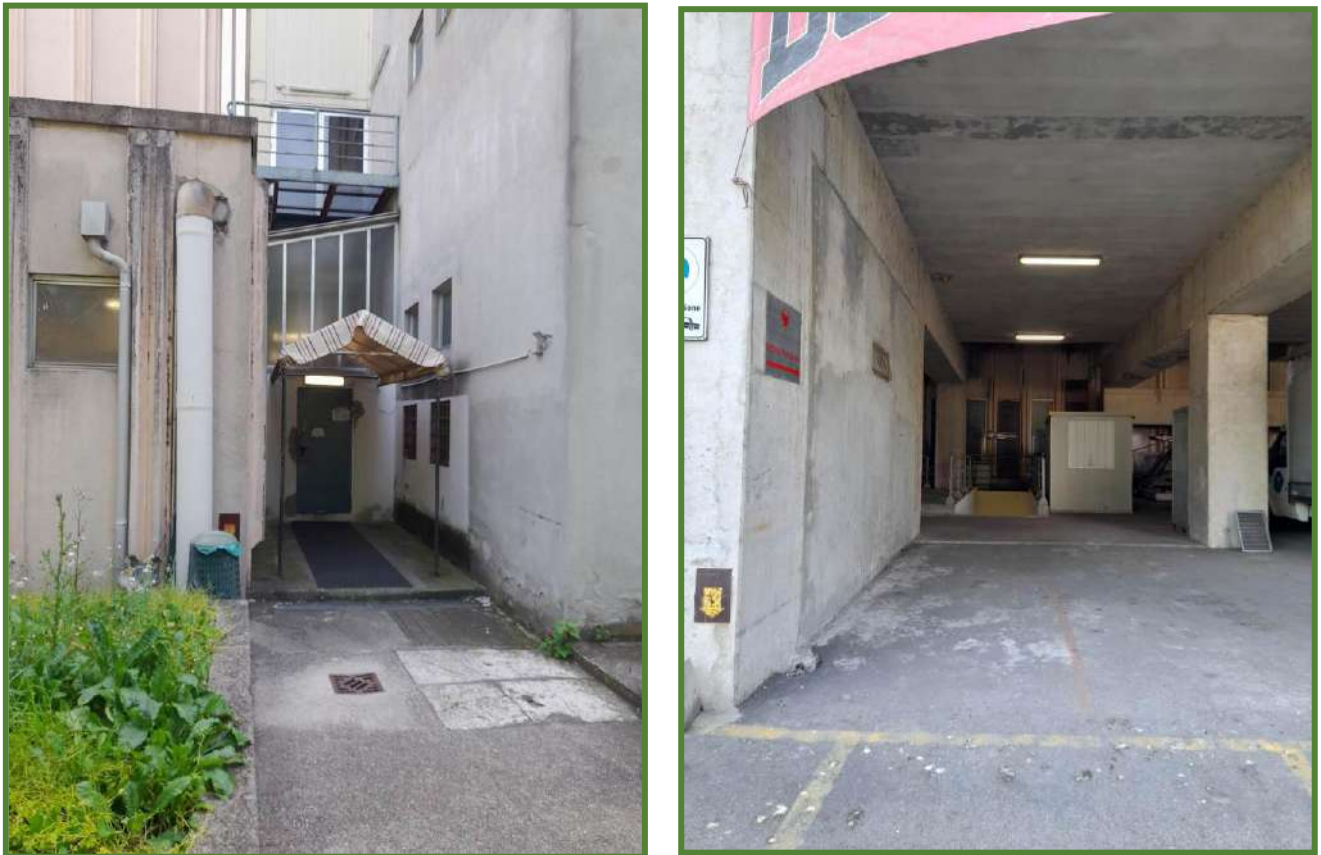
Figura 13: Ingresso boxe ai locali piano seminterrato a sinistra – uscita di sicurezza dei locali boxe del livello interrato a destra
