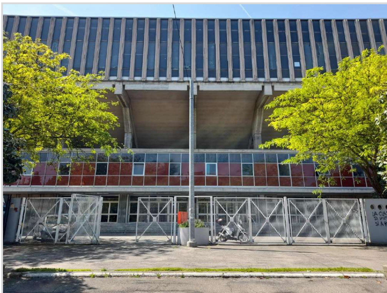
Figura 4 – Il fronte del fabbricato su via Pellico e i cancelli di accesso pedonale
