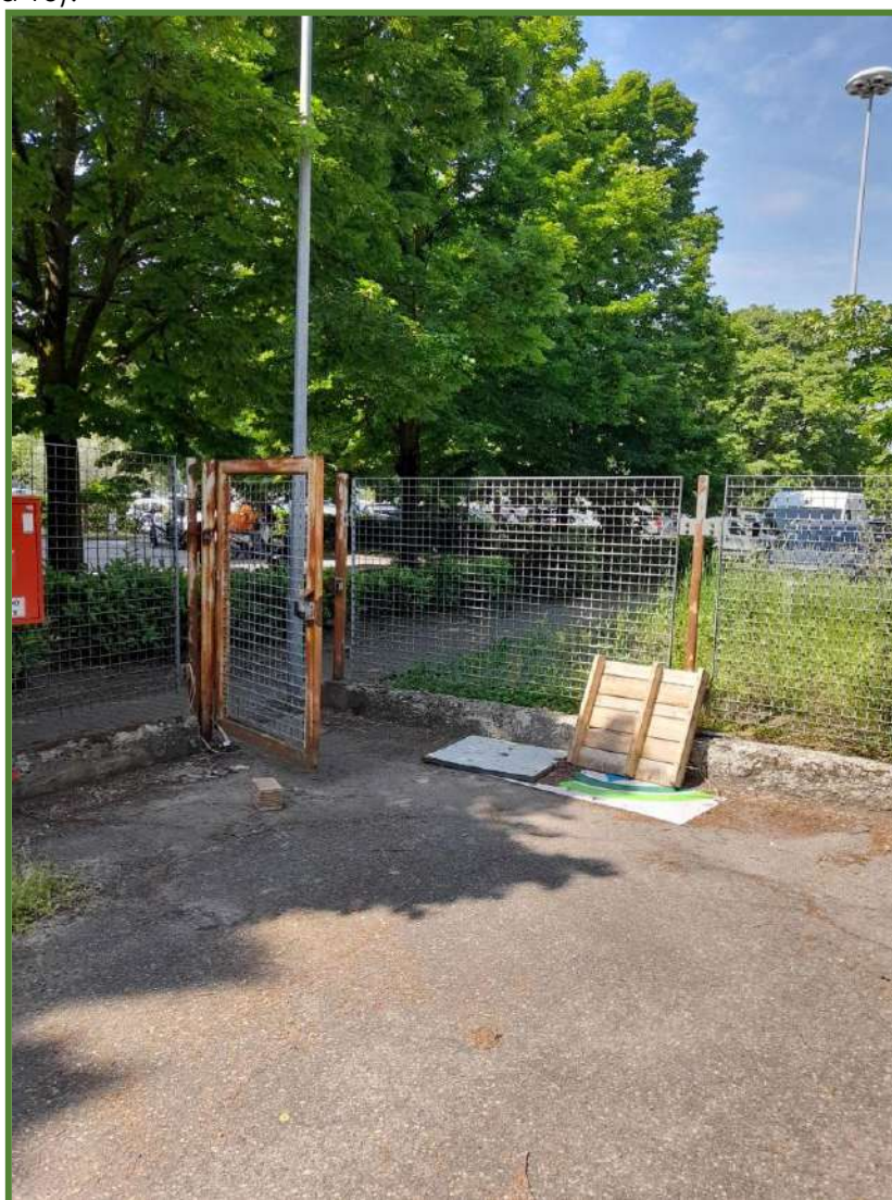
Figura 12: Cancelli pedonale sud-ovest per accesso locali boxe
