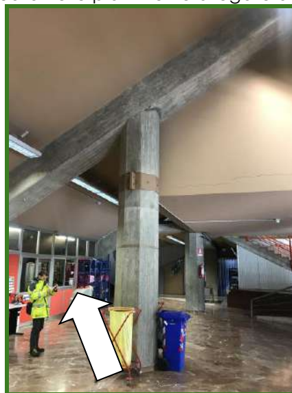
Figura 14: Atrio di ingresso, a sinistra il locale portineria
