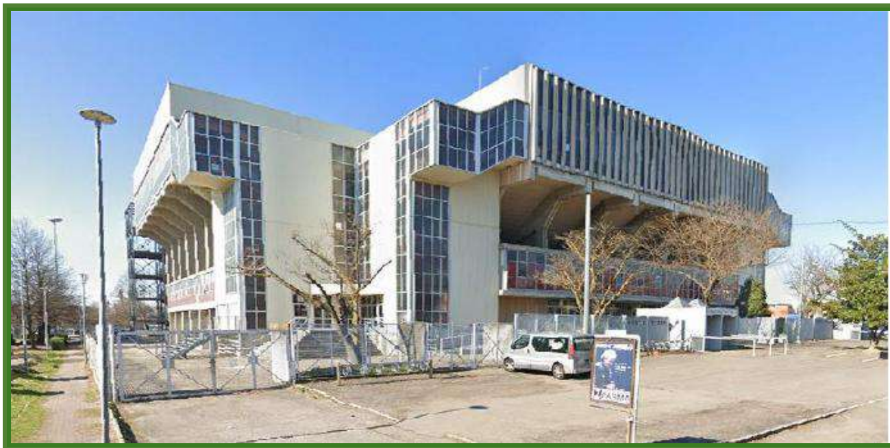
Figura 3: Vista del fabbricato da via Silvio Pellico
