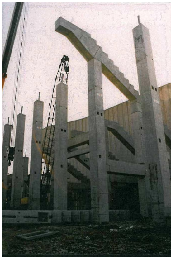
Figura 9: Immagini della costruzione degli ampliamenti
