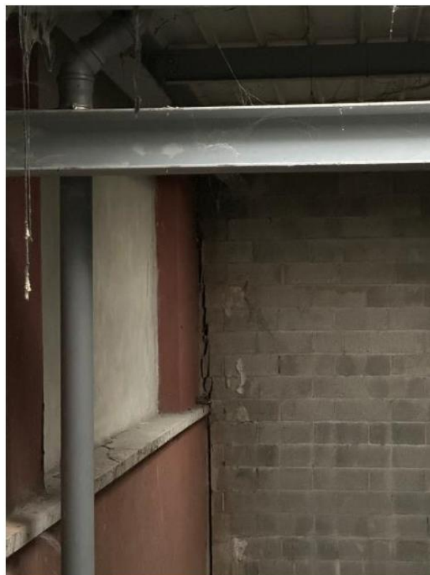
Tamponature delle appendici in carpenteria metallica lungo Via Basetti
