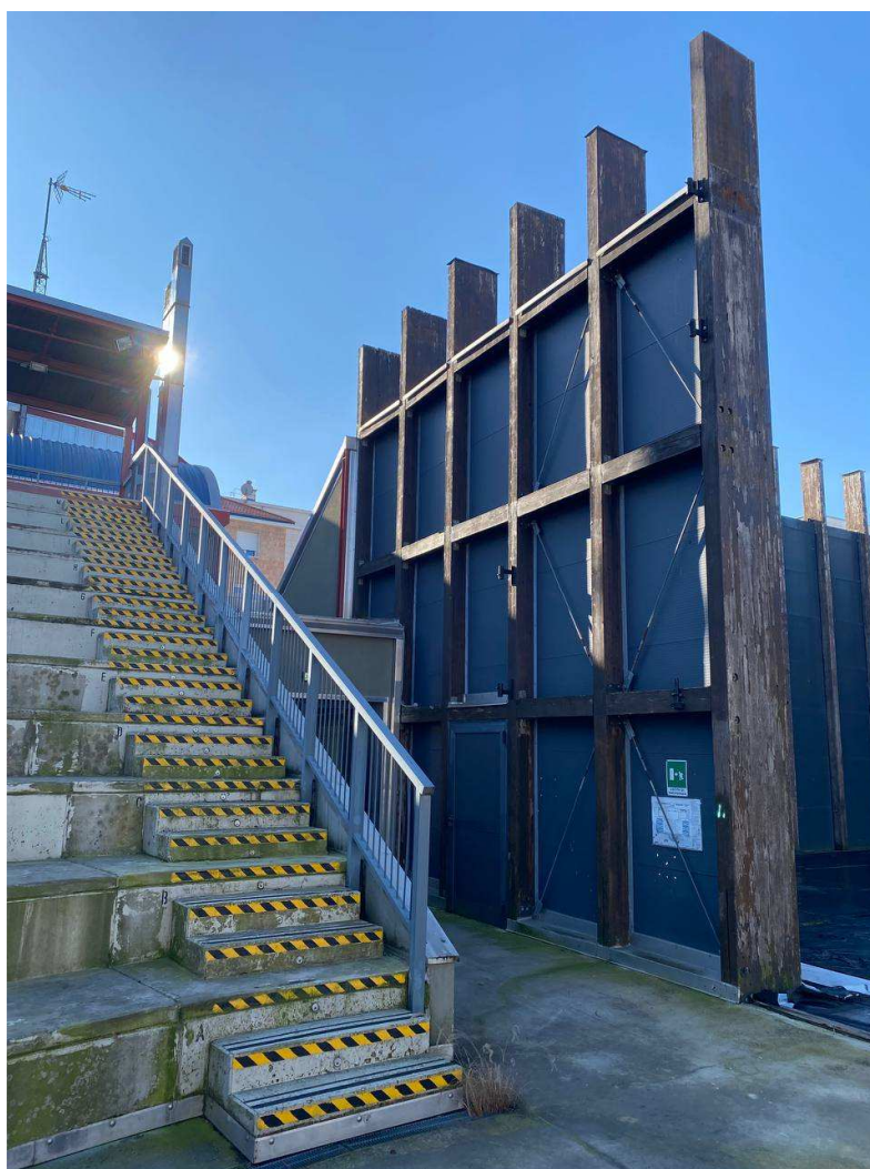
Arena Shakespeare – dettaglio struttura esistente
