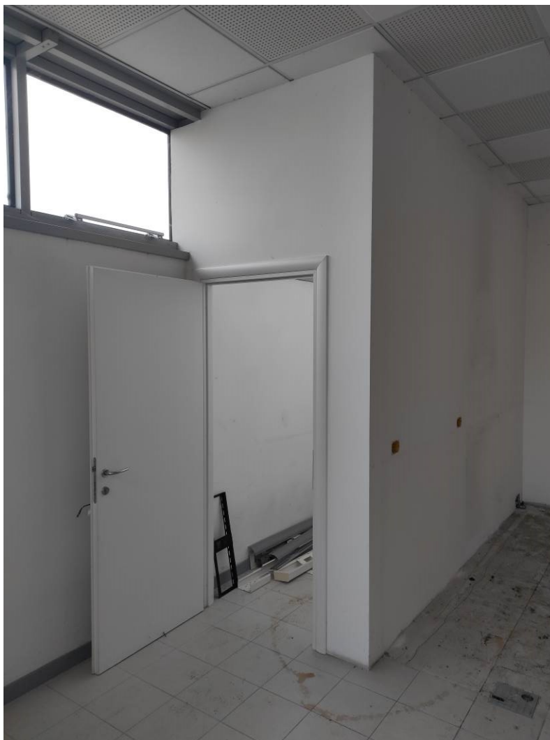
Figura 10: Ripostiglio ex area bar
