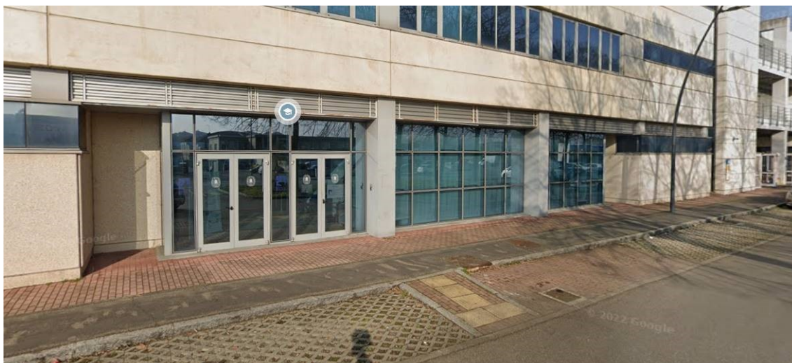
Figura 1: Vista da via dei Mercati (accesso pedonale)
