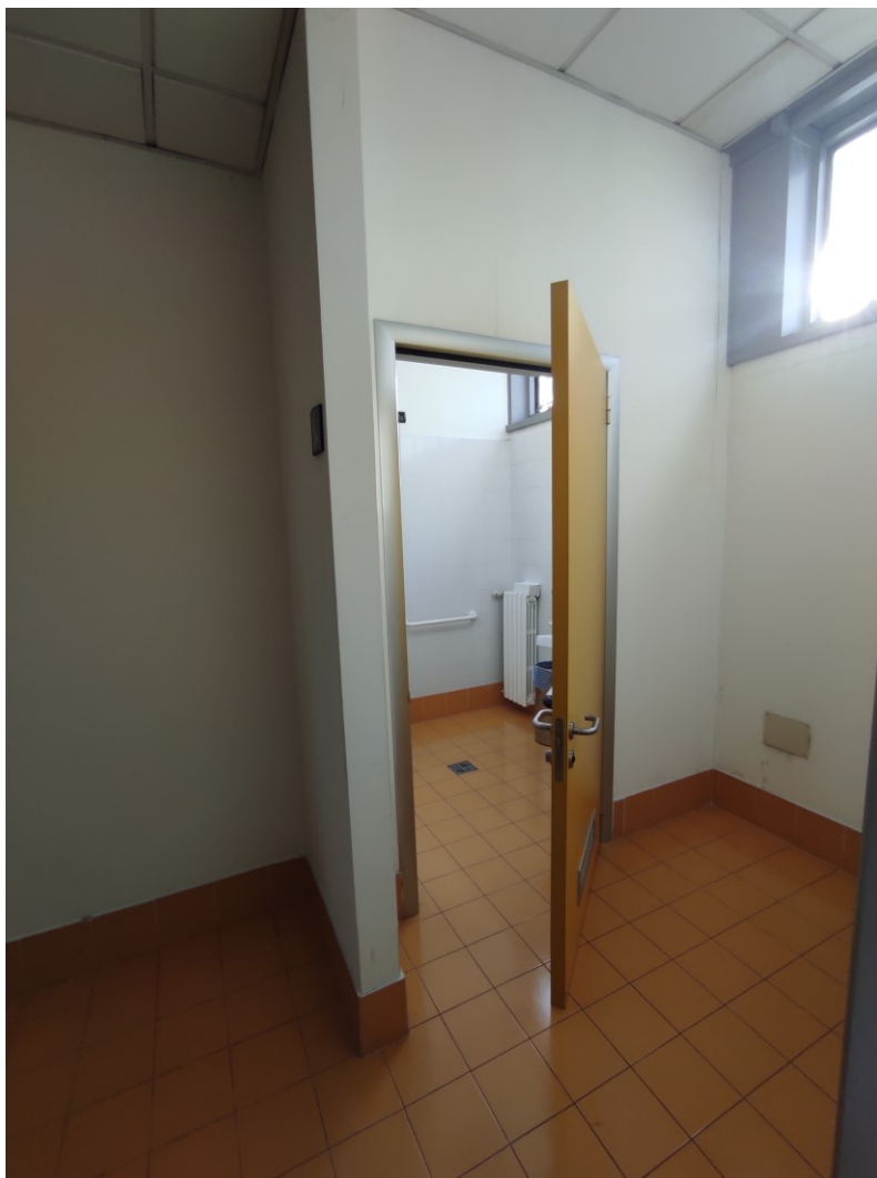
Figura 8: Vista bagno disabili
