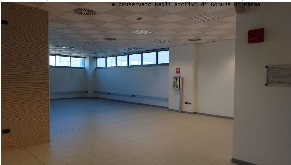
Figura 6: Vista sala contrattazioni (porzione est)
