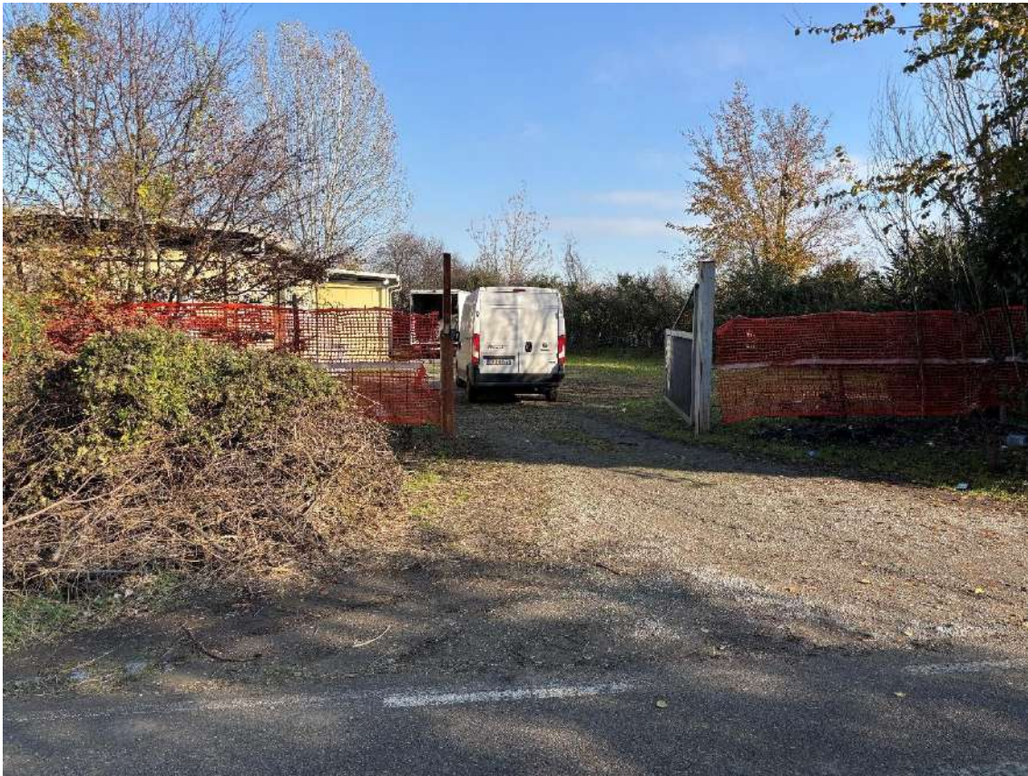
Figura 4 Vista ingresso dal cancello su strada Cornocchio, che sarà utilizzato come accesso di cantiere
