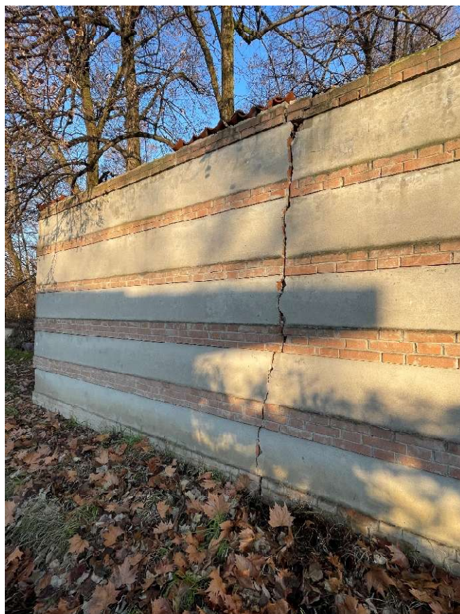
Figura 5 : Muro di confine con Parco Ducale, su cui effettuare scusi – cusi
