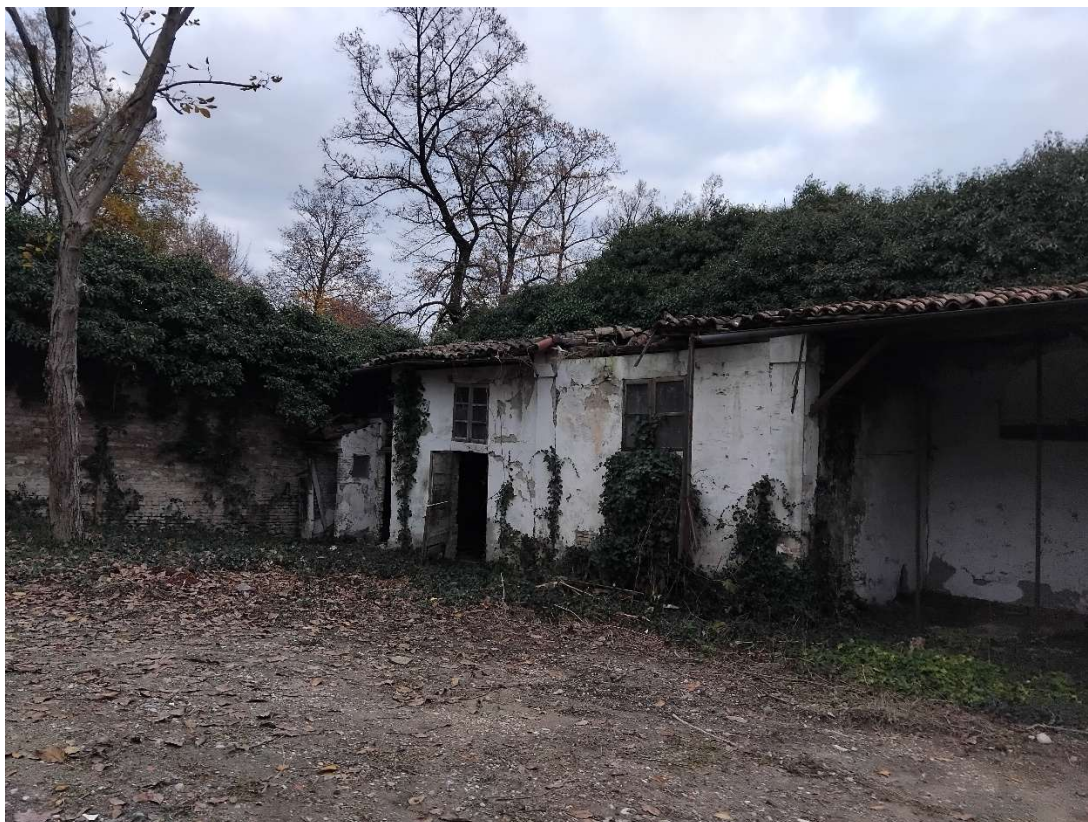
Figura 3 : Edificio abbandonato, lato Parco Ducale
