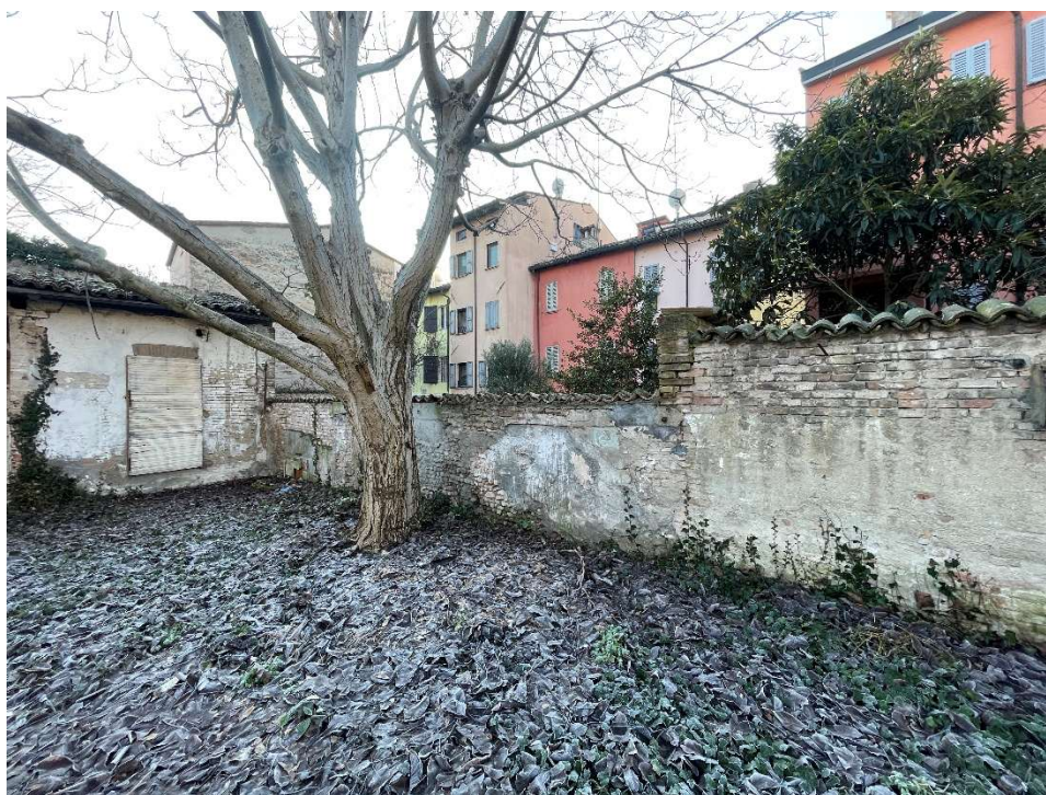
Figura 6 : muro di confine con isolato residenziale da cui staccarsi con una recinzione spostata verso l'interno dell'area
