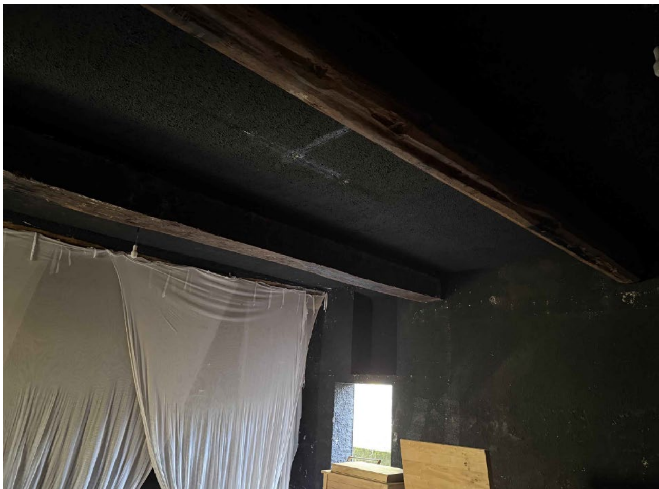
Teatro del Vicolo – dettaglio del soffitto con travi a vista dello spazio centrale
