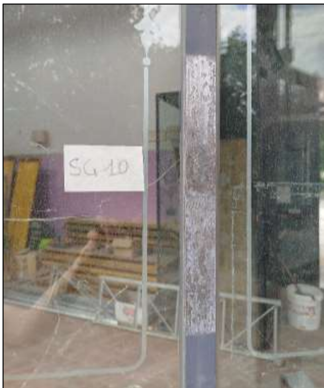
Infisso in metallo e vetro. Particolare del metallo (acciaio comune) con tracce di vernice grigio chiaro.
