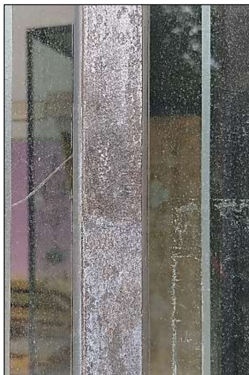
Infisso in metallo e vetro. Particolare del metallo (acciaio comune) con tracce di vernice grigio chiaro.
