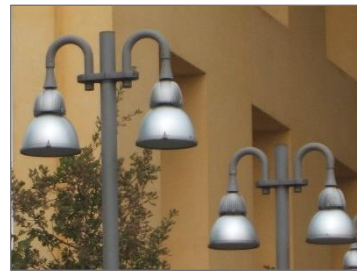
Fig 1 e 2 - Illuminazione rivolta verso il basso, con apparecchi che non consentono la dispersione luminosa verso l'alto: Auditorium Paganini, Parma
