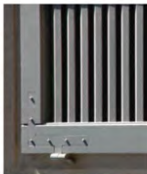
ANGOLARI METALLICI INTEGRATI NEL SERRAMENTO
