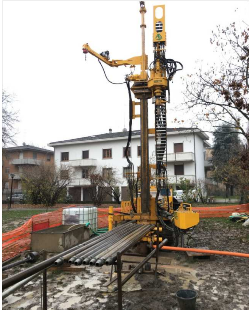
Posizionamento sondaggio
