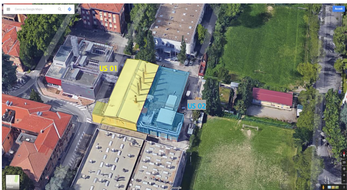
Fig. 4.4 – La centrale termica.
