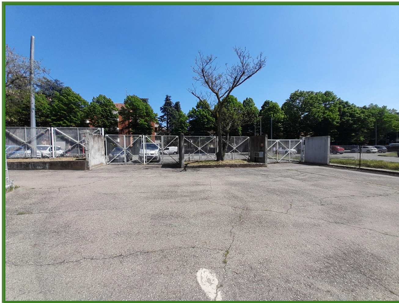
Figura 7 – Cancelli carrabili di accesso da via Silvio Pellico
