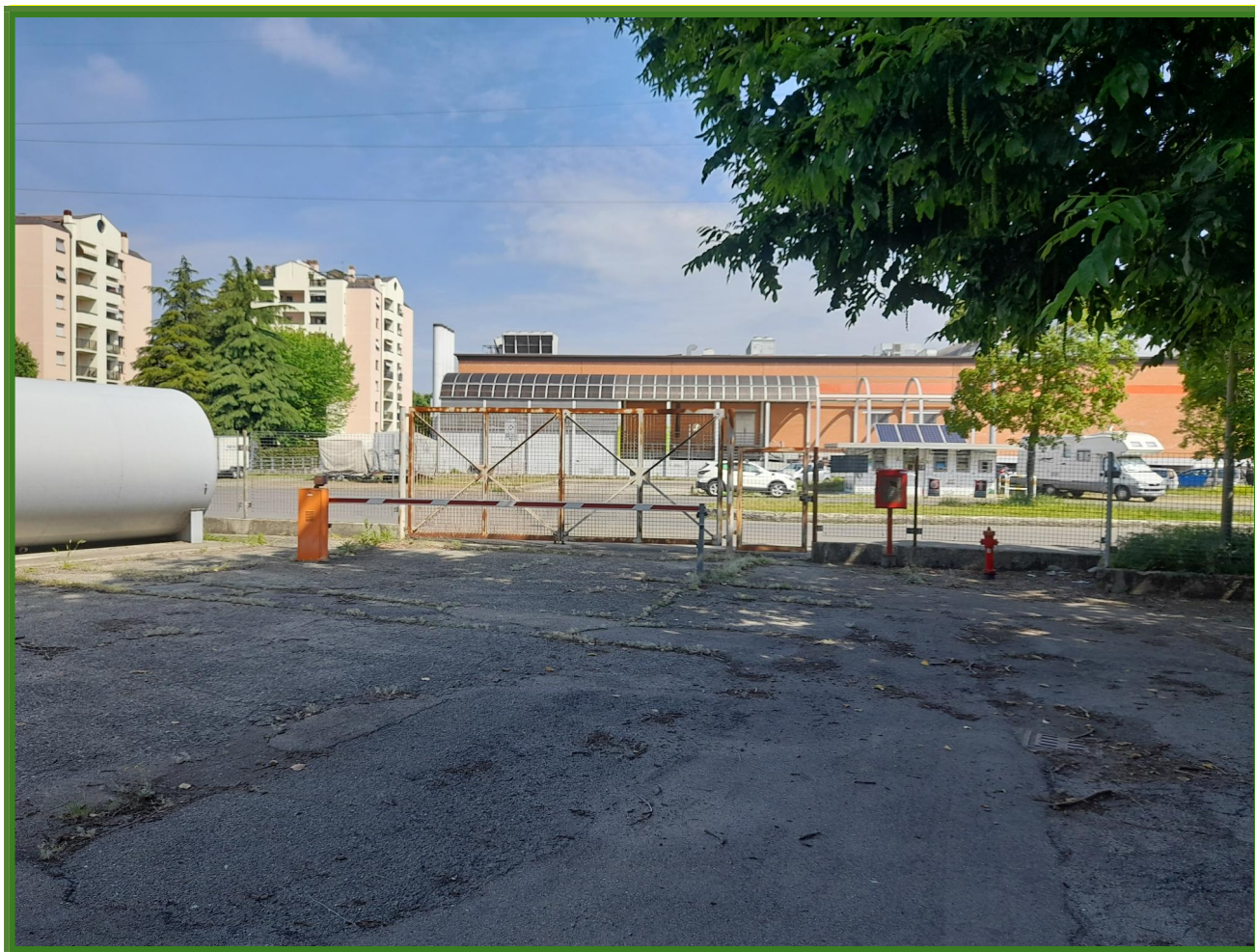
Figura 8 – Cannello carrabile di accesso dal parcheggio a nord dell'area
