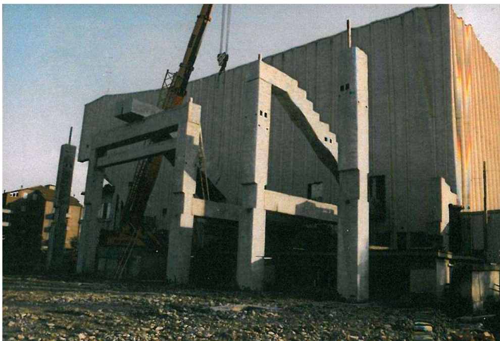
Figura 10: Immagini della costruzione degli ampliamenti
