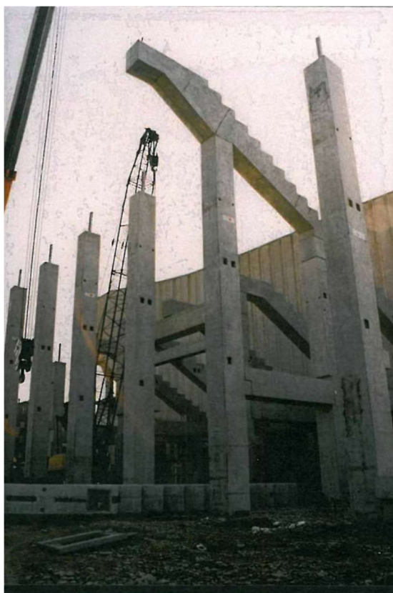
Figura 9: Immagini della costruzione degli ampliamenti
