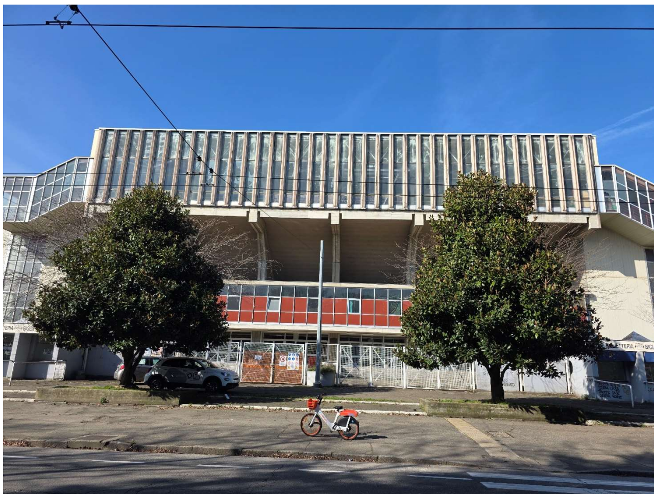
Figura 21 - Vista del fronte principale su via Silvio Pellico
