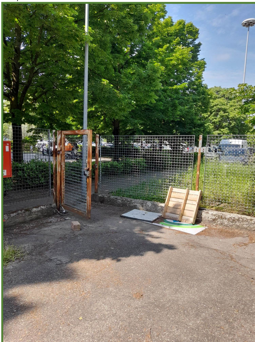
Figura 12: Cancelli pedonale sud-ovest per accesso locali boxe
