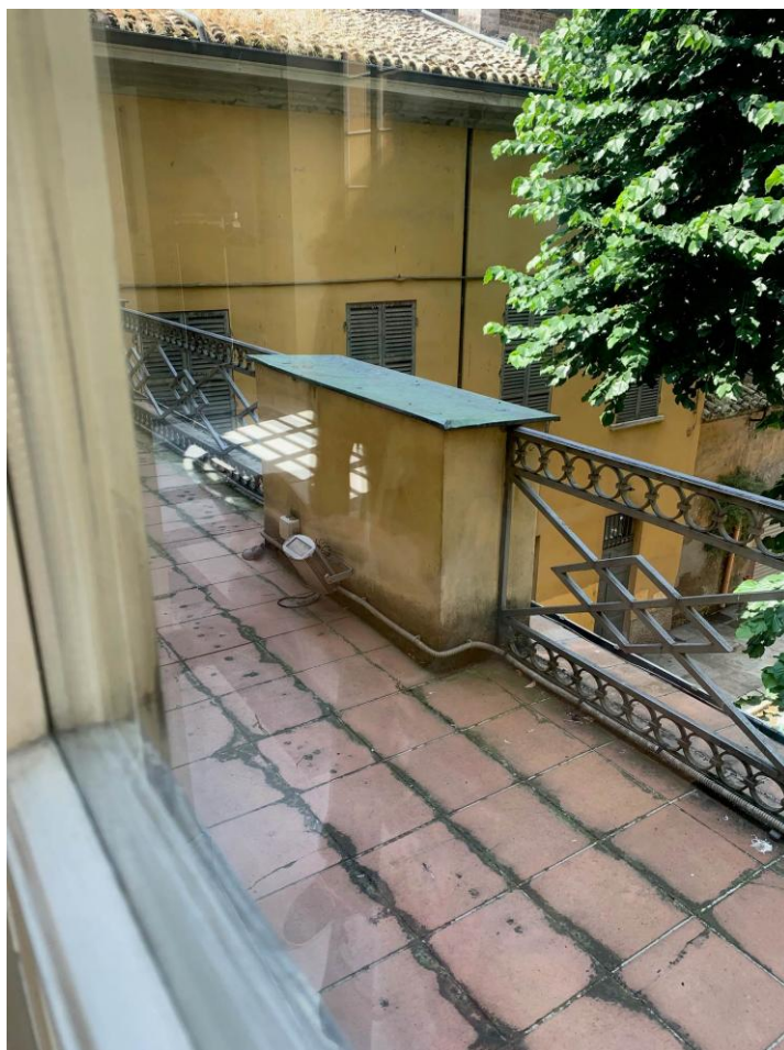
Foto 13 – Balconata prospetto Ovest
