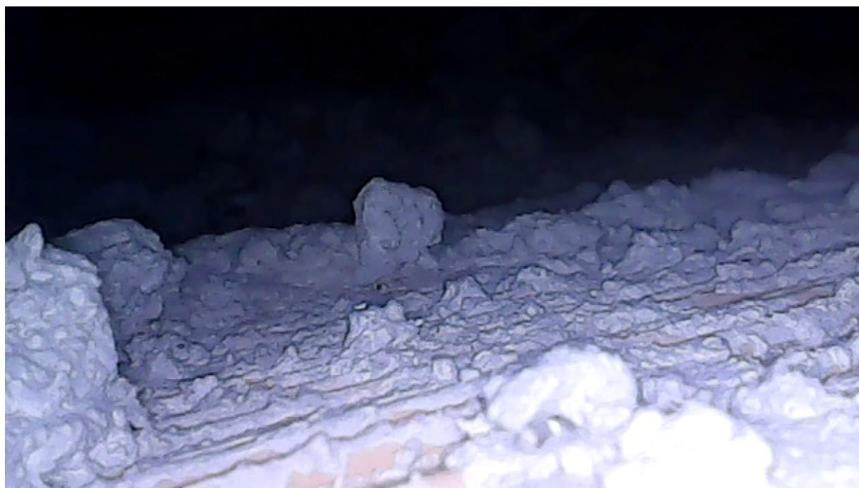
Foto 20 - Foto endoscopica della volta in cannucciato al primo piano
