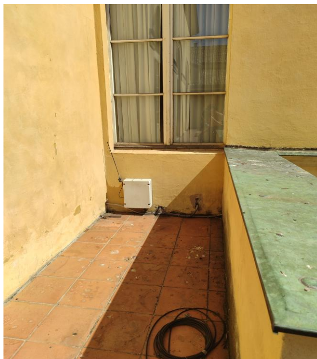
Foto 9 – Balconata prospetto Est
