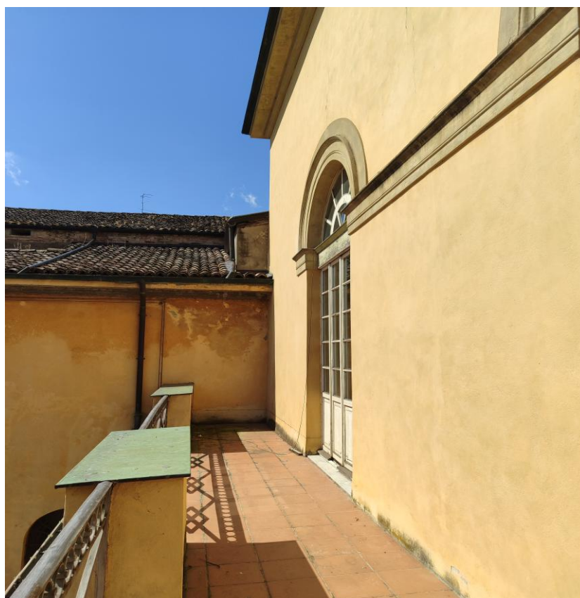
Foto 8 – Balconata prospetto Est
