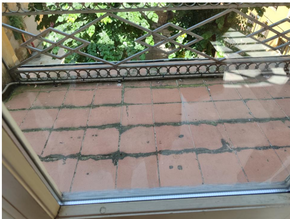
Foto 14 – Balconata prospetto Ovest
