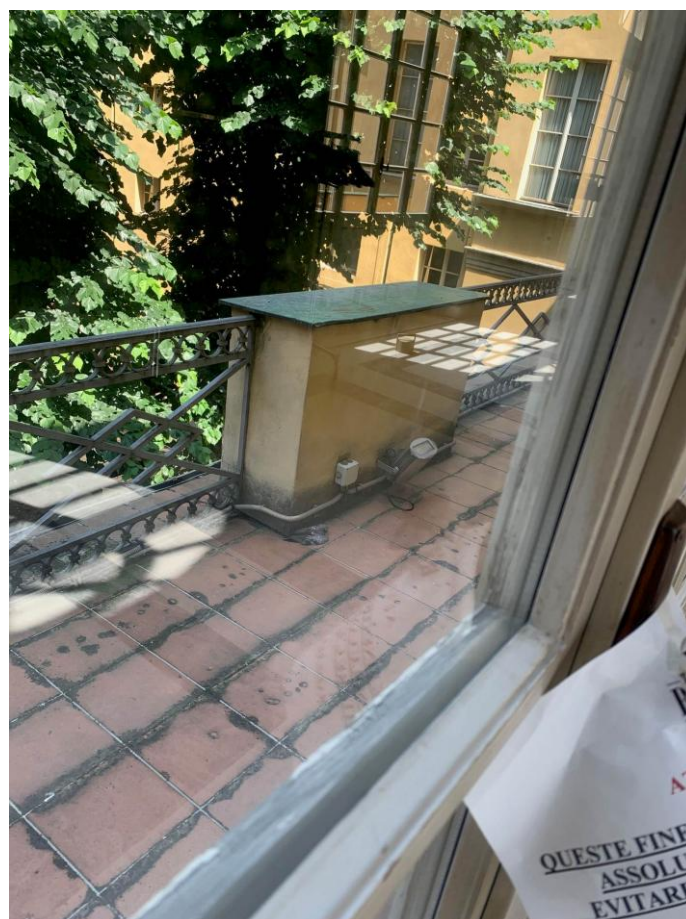
Foto 12 – Balconata prospetto Ovest
