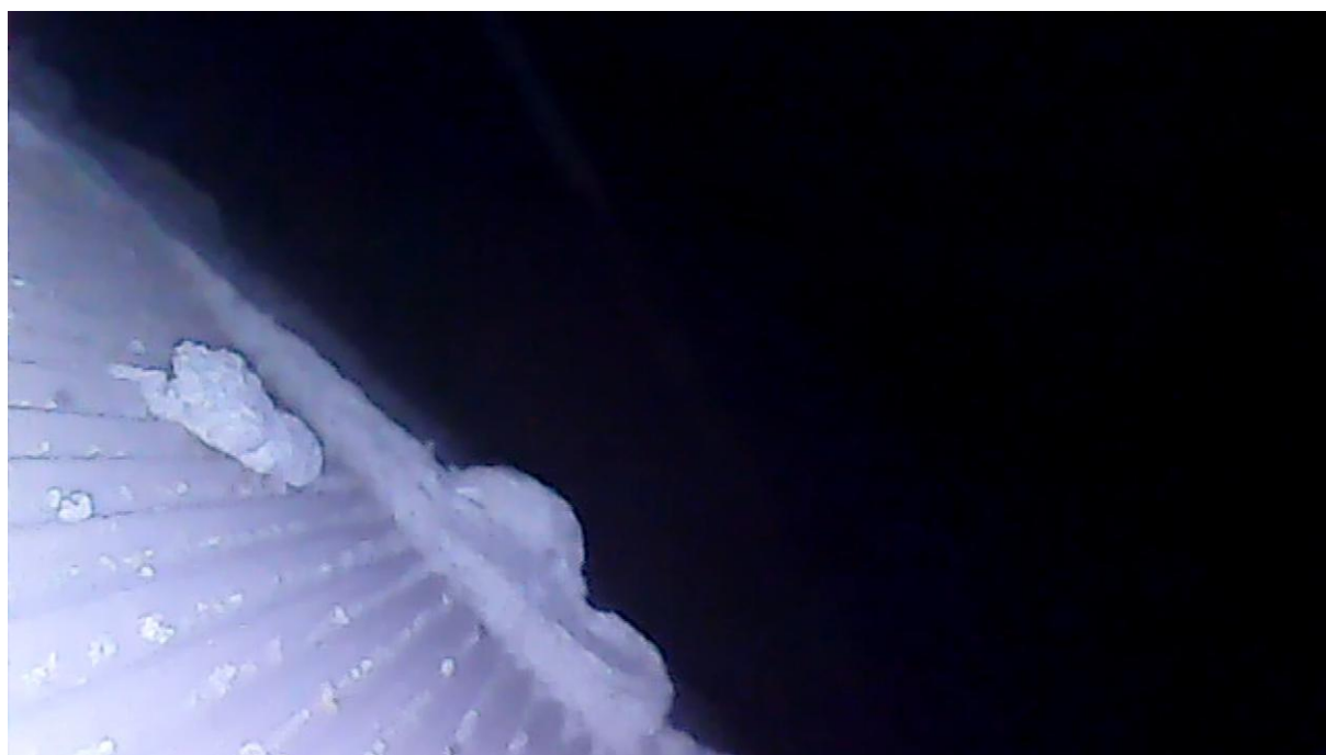
Foto 21 - Foto endoscopica della volta in cannucciato al primo piano
