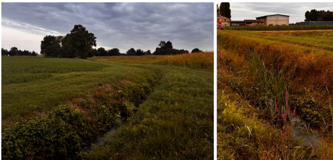
Figura 6.1 – immagini relative all'ambito Marzola (a dx relativo alla stazione di monitoraggio V4; a sx verso la confluenza nel cavo Formica, nei pressi dell'abitato di San Donato).
