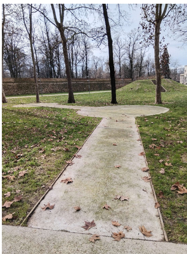
Figura 2 : percorso già realizzato destinato al posizionamento dei giochi su pavimentazione antitrauma
