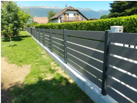
Foto 4 (particolare della recinzione)
