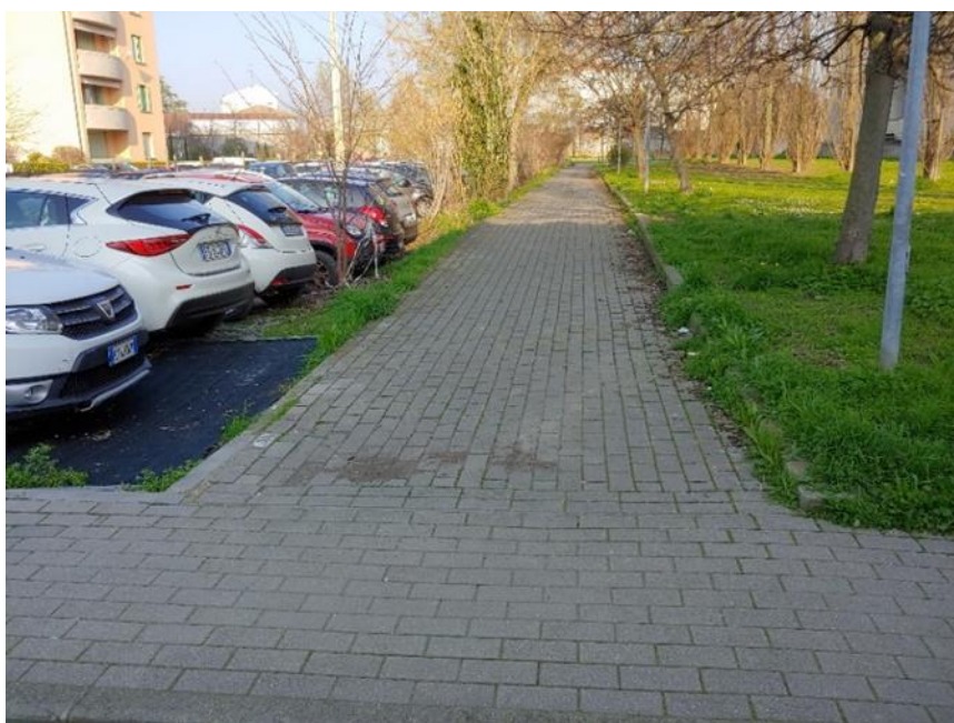
Figura 8 - Vista percorso pedonale Sud
