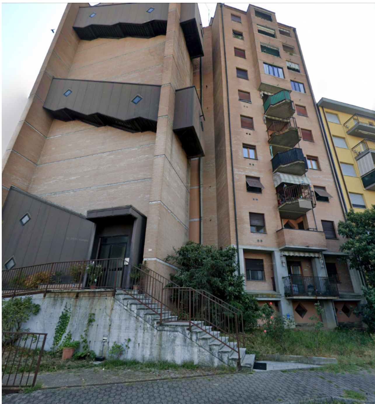
Figura 9 Facciata ovest dell'edificio in Via Gramatica. Le facciate, comprese le balaustre dei balconi rettangolari, sono in mattoni faccia a vista. L'edificio è più alto di 24 m.
