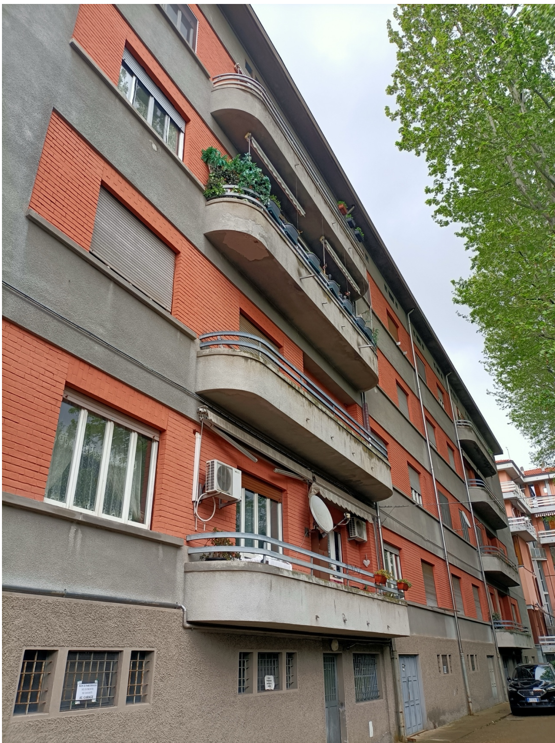
Figura 7 Edificio di via Rondizzoni – Facciata sud. Come si può osservare solo i balconi della colonna a sinistra (civico n. 6) non sono interessati dall'avere esattamente di fronte alberi ad alto fusto. Uno di questi presenta evidenti segni di ammaloramento. Eccetto quello di piano terra, gli altri tre balconi avrebbero un soleggiamento discreto. I balconi presentano un fronte rettilineo di 6,9 m (quindi potrebbero ospitare tra moduli da 500 W). Bisogna verificare se questi tre balconi sono di appartamenti di proprietà del Comune di Parma.
