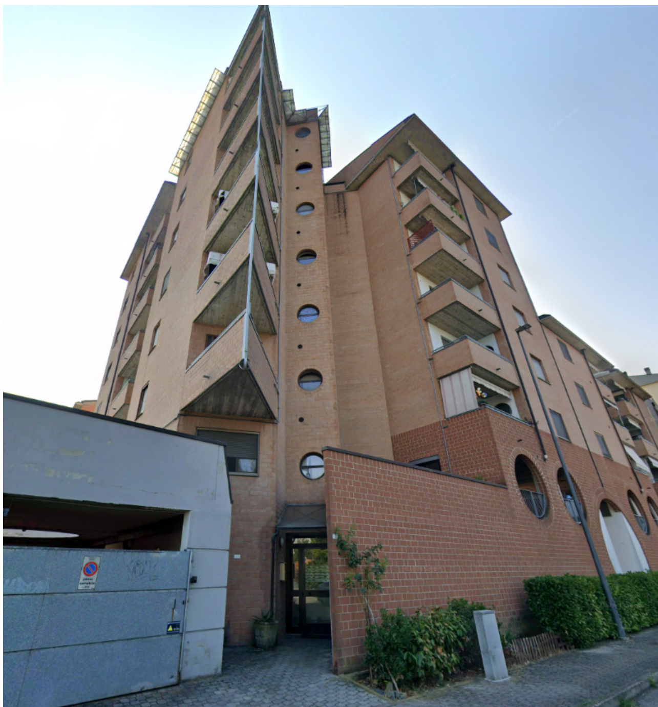
Figura 8 Edificio di via Corrado – vista da angolo nord/ovest. Le facciate, comprese le balaustre dei balconi, sono in mattoni faccia a vista. L'edificio è più alto di 24 m.
