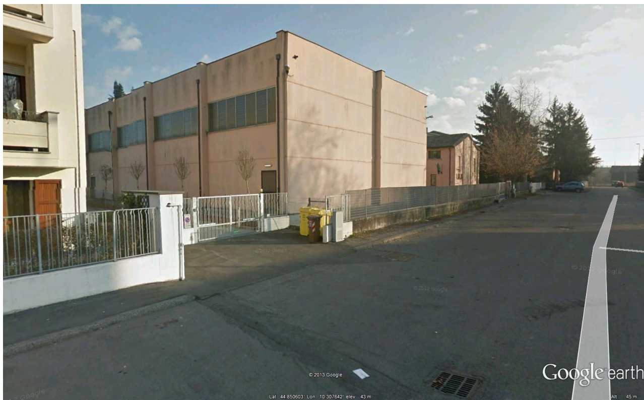
Foto 3: Prospetto nord- ovest dell'edificio
