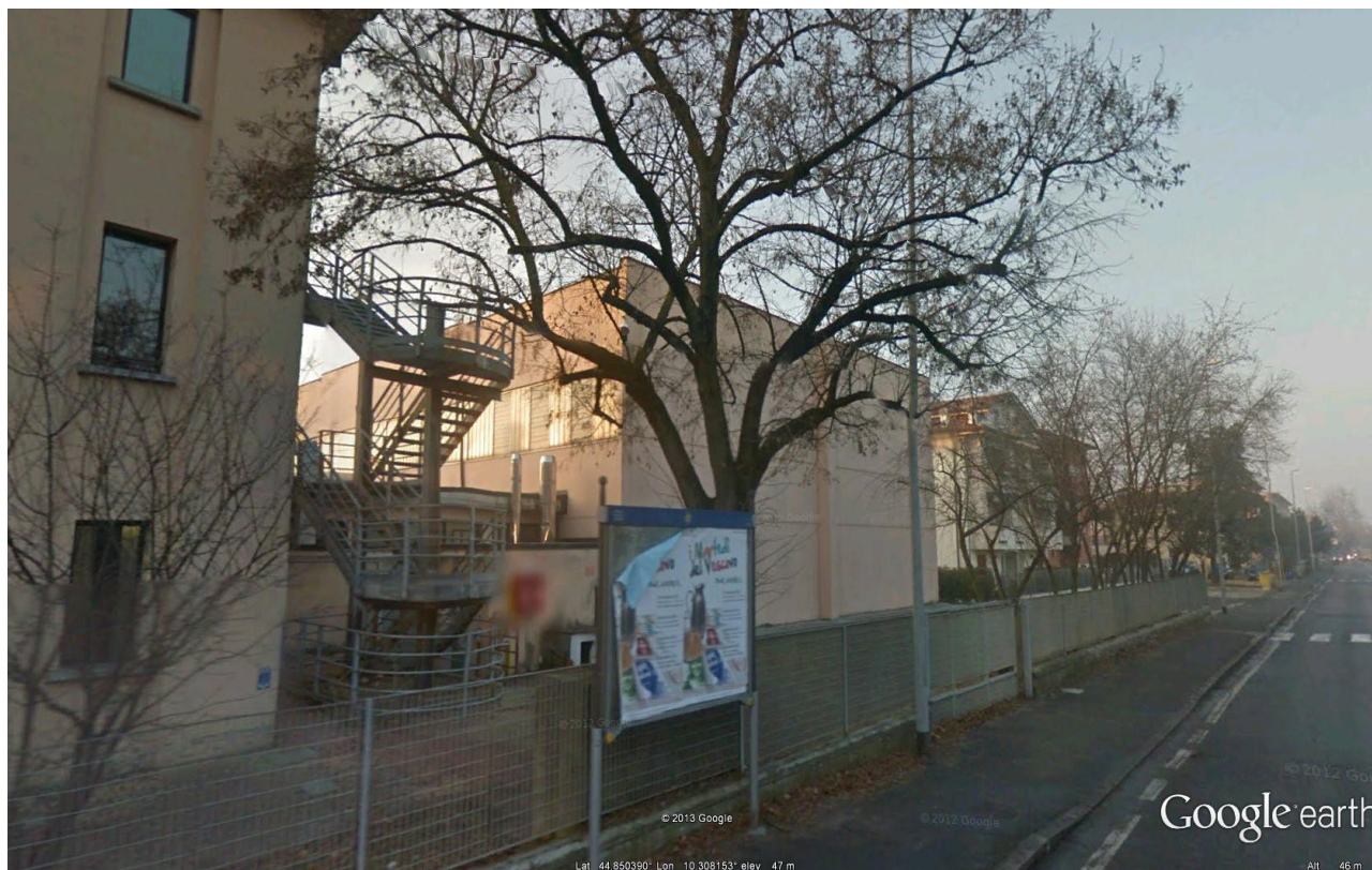
Foto 5: Prospetto Sud - Est dell'edificio
