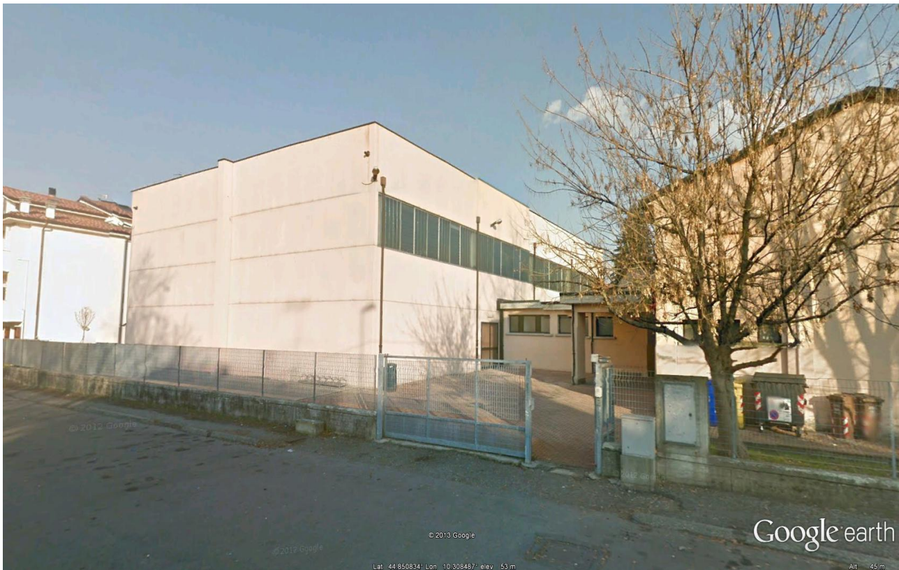
Foto 2: Prospetto sud-ovest dell'edificio
