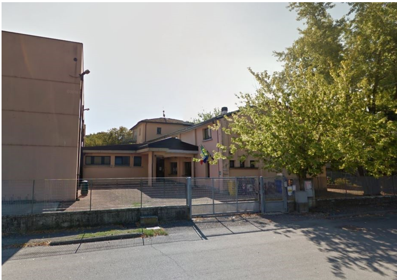
Figura 9 – Ingresso principale del complesso da Via Cornacchia 5
