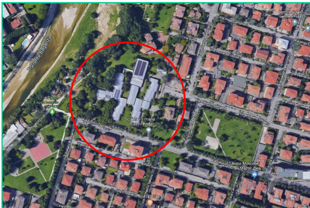
4 – L'edificio della scuola primaria Rodari nel contesto urbano
