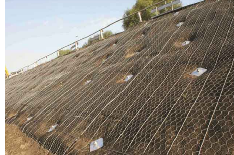
VISTA INTERVENTO DI SOIL-NAILING PRE INERBIMENTO DELLA SCARPATA
