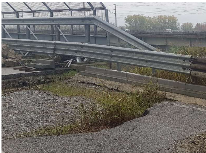
Figura 6: Approccio al ponte della linea ferroviaria
