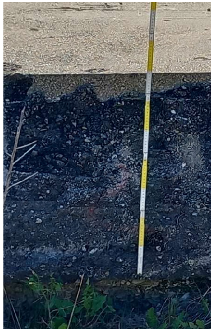
Figura 3: Pavimentazione in corrispondenza delle ricariche
