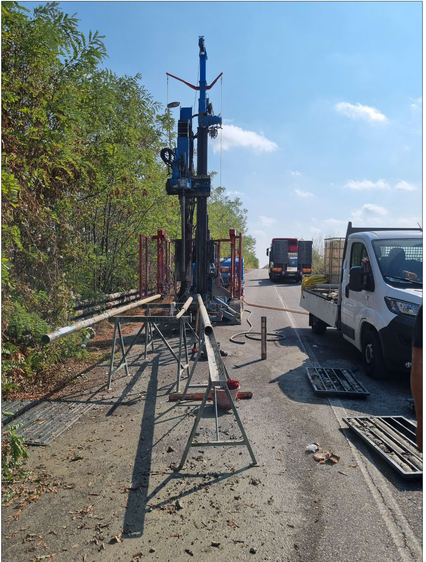
RAPPRESENTAZIONE FOTOGRAFICA - Sondaggi Via Versailles PIAZZAMENTO SONDAGGIO CC-04 - Comune di Parma
