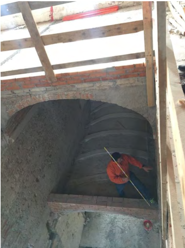
1 – Ammezzato della scala: consolidamento.
