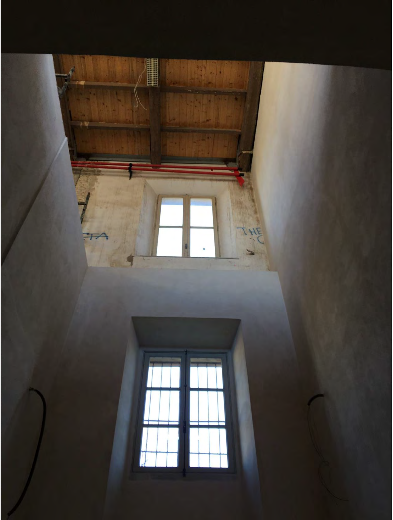
5 – vista interna del vano dove verrà collocata la nuova scala metallica da piano primo alla copertura – lato finestre
