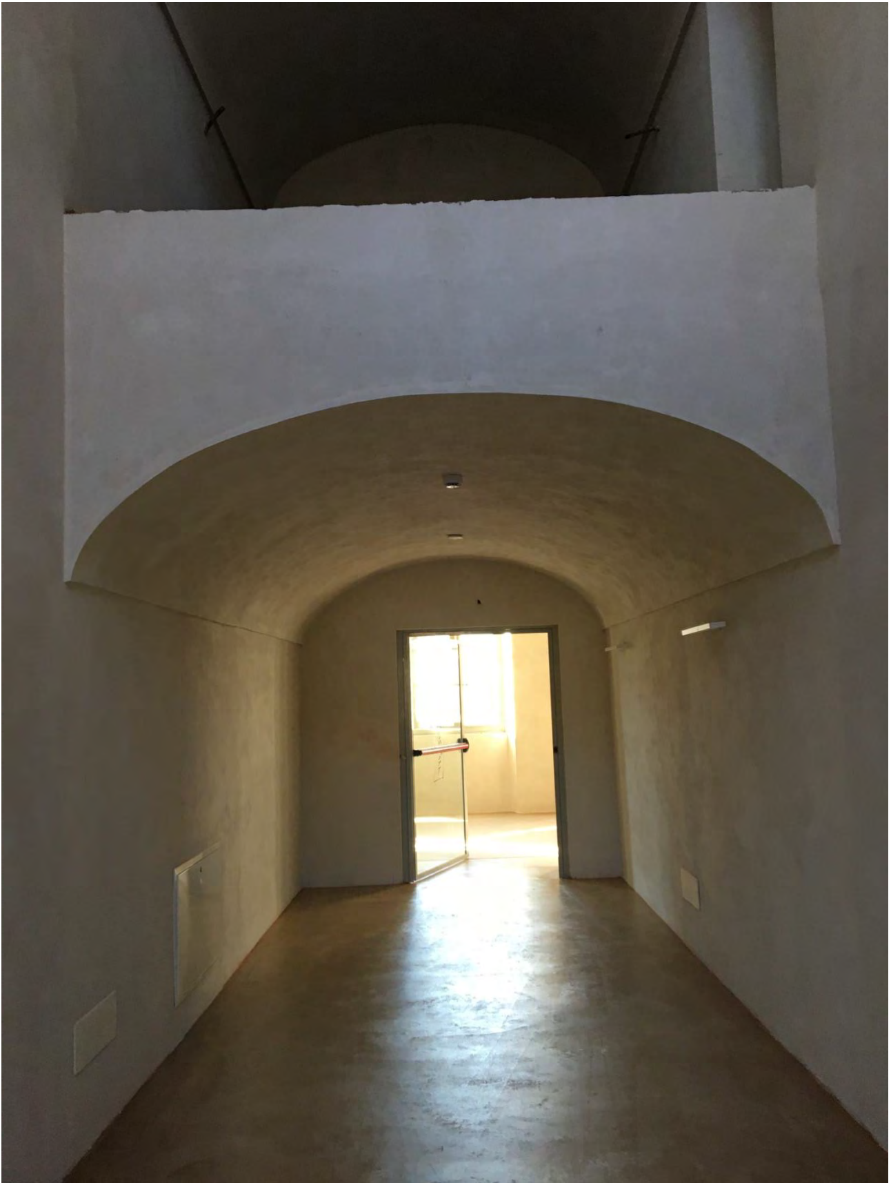
7 – vista interna del vano dove verrà collocata la nuova scala metallica ingresso al piano primo
