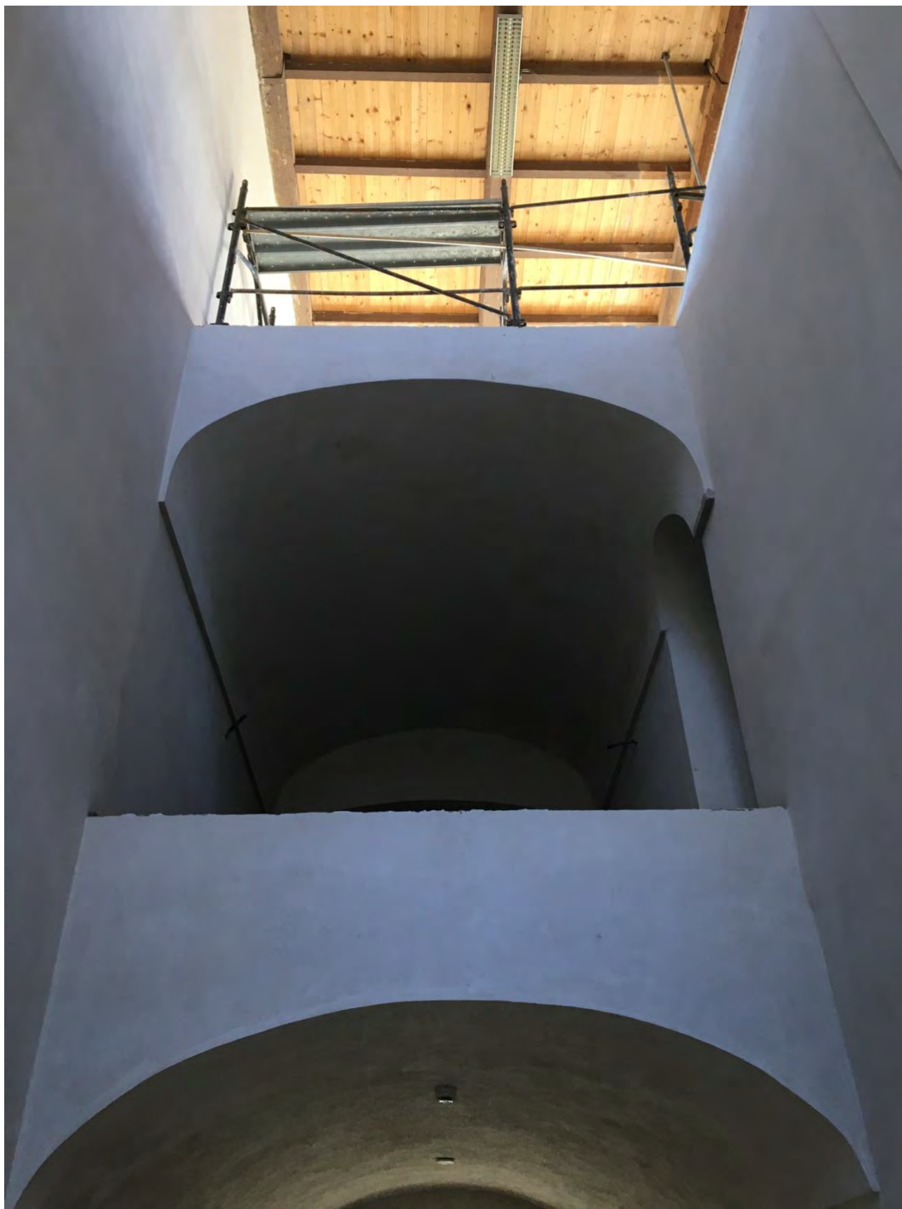
6 – vista interna del vano dove verrà collocata la nuova scala metallica da piano primo alla copertura – lato ingresso e sbarco
