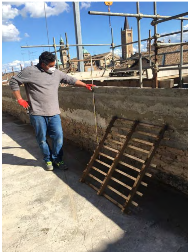
10 – Parapetto del terrazzo durante il restauro
