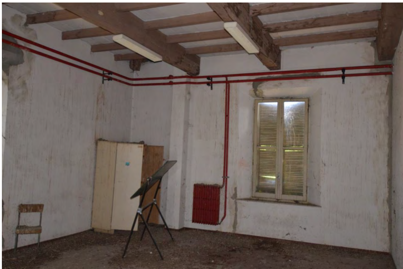
13 – vista interna del locale posto a sud-ovest: parete ovest
