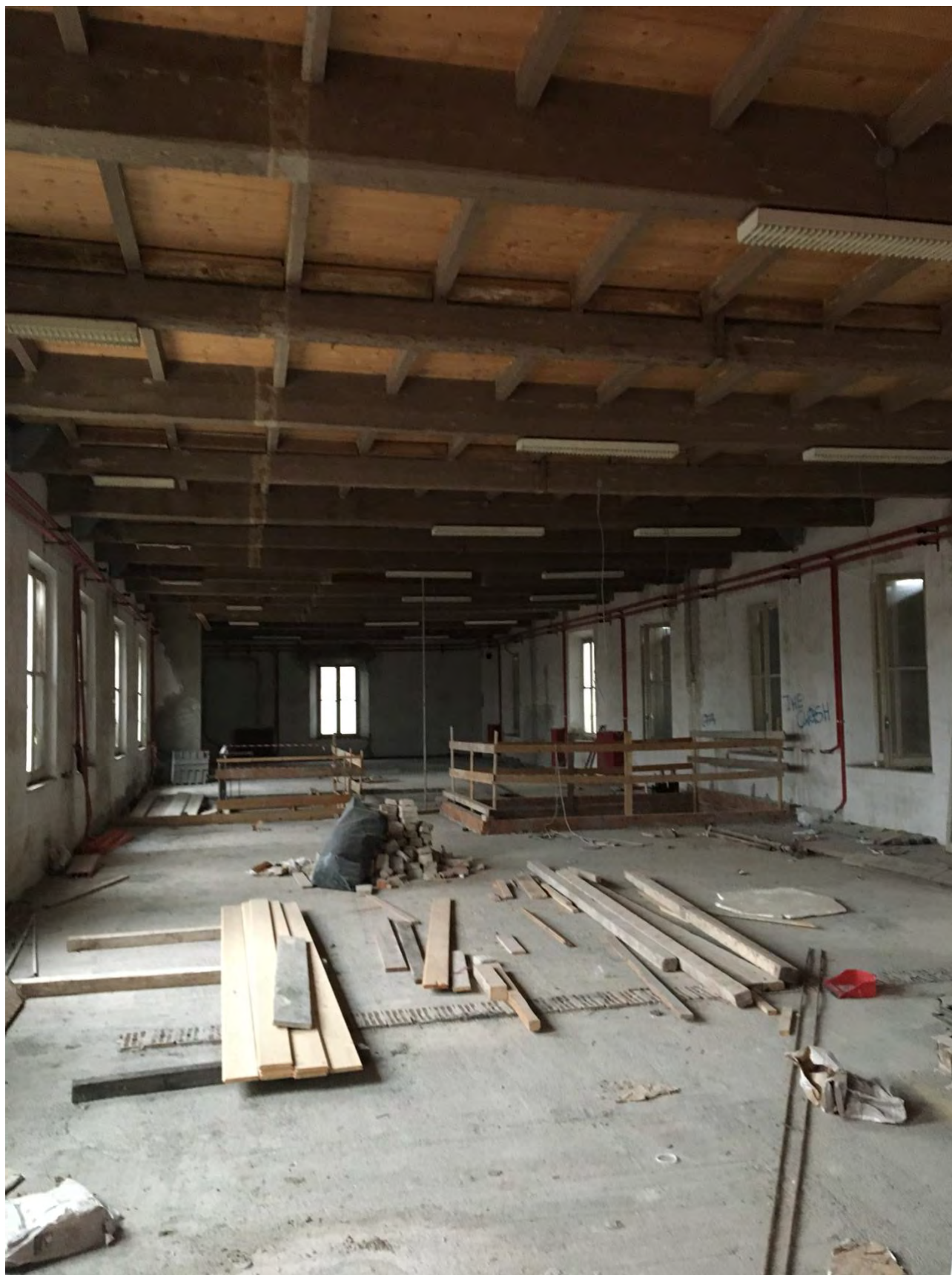
1 – Sala interna prima della realizzazione delle pareti centrali.
