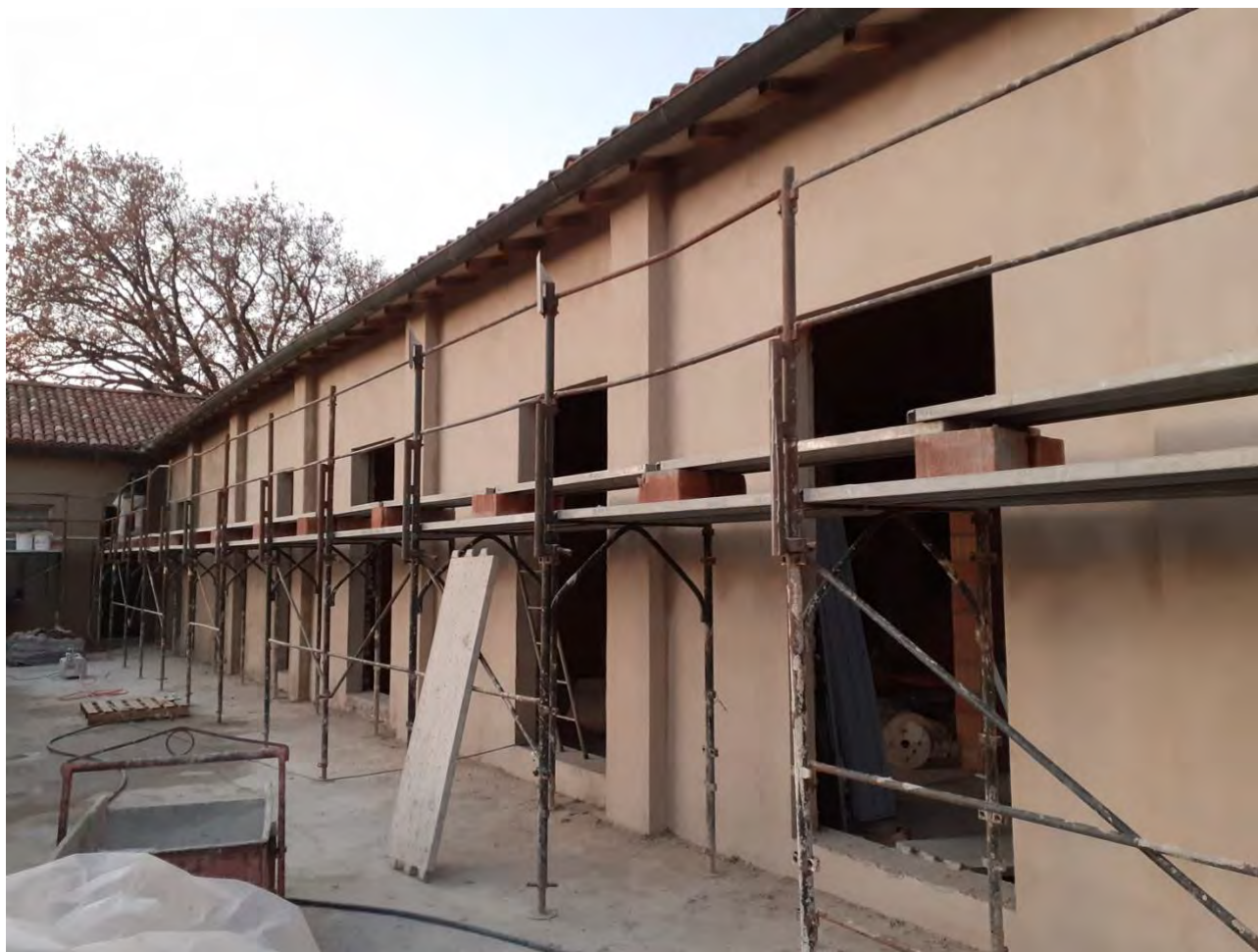
8 – Facciata sul terrazzo con intonaci già realizzati
