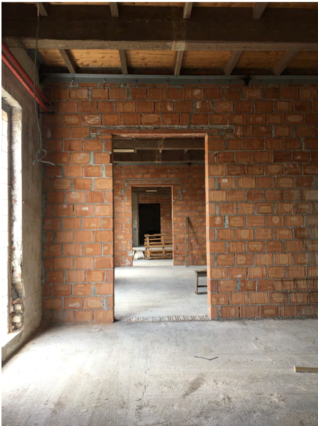
6 – Vista interna dei locali dopo la realizzazione di setti interni
