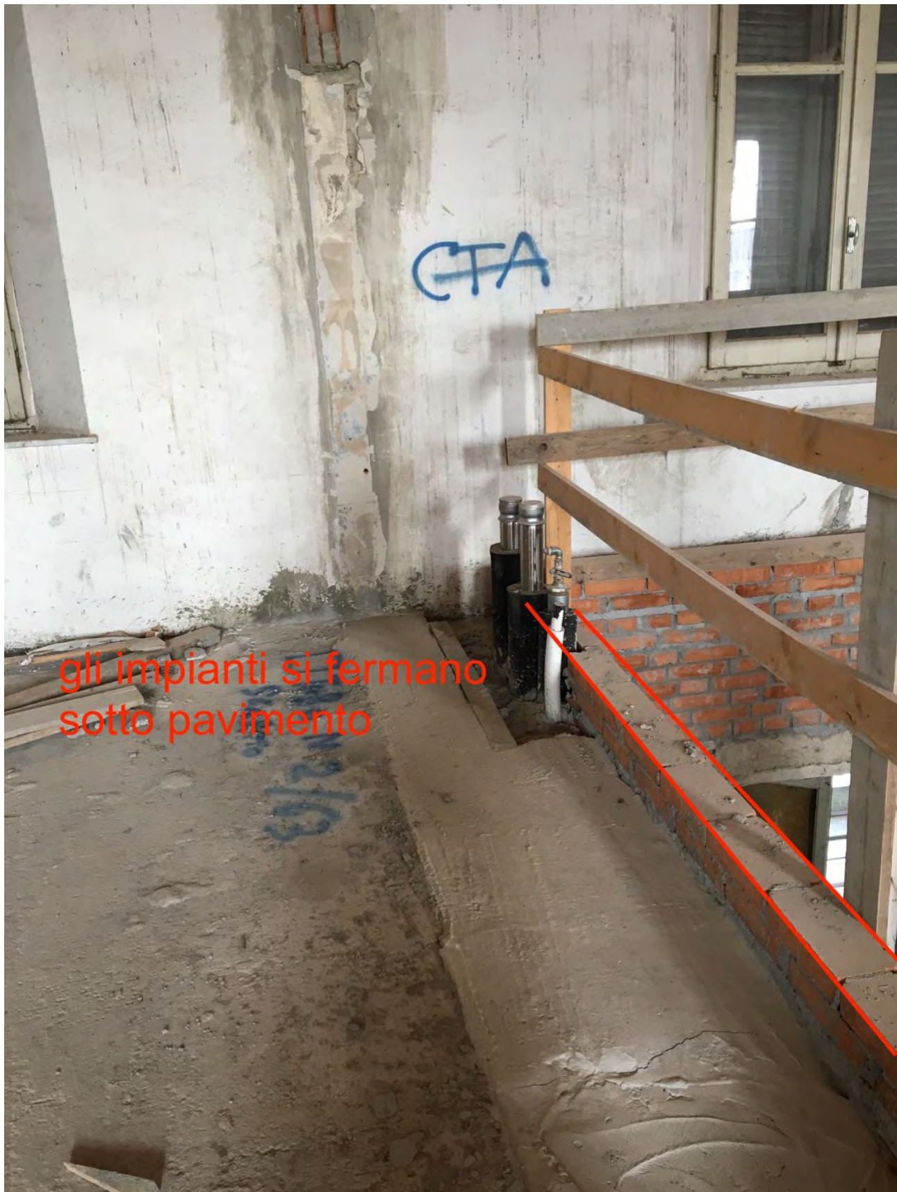
7 – Punto di arrivo degli impianti al piano secondo. La posizione corrisponde ad un'asola continua da piano terra al piano secondo, realizzata in accosto alla parete del vano della nuova scala metallica
