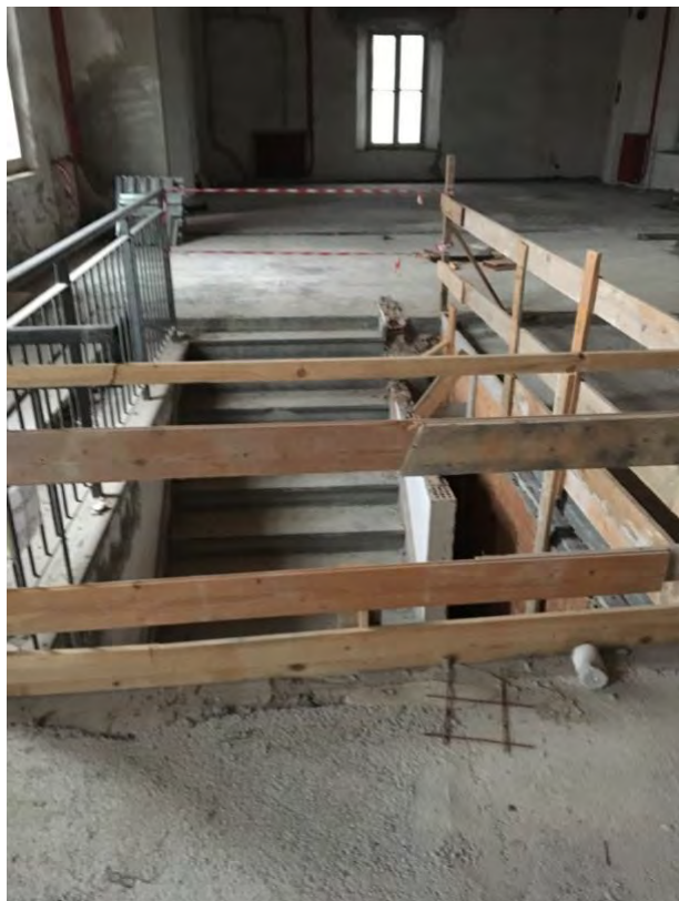
2 – 3 – Dettaglio della scala da chiudere
