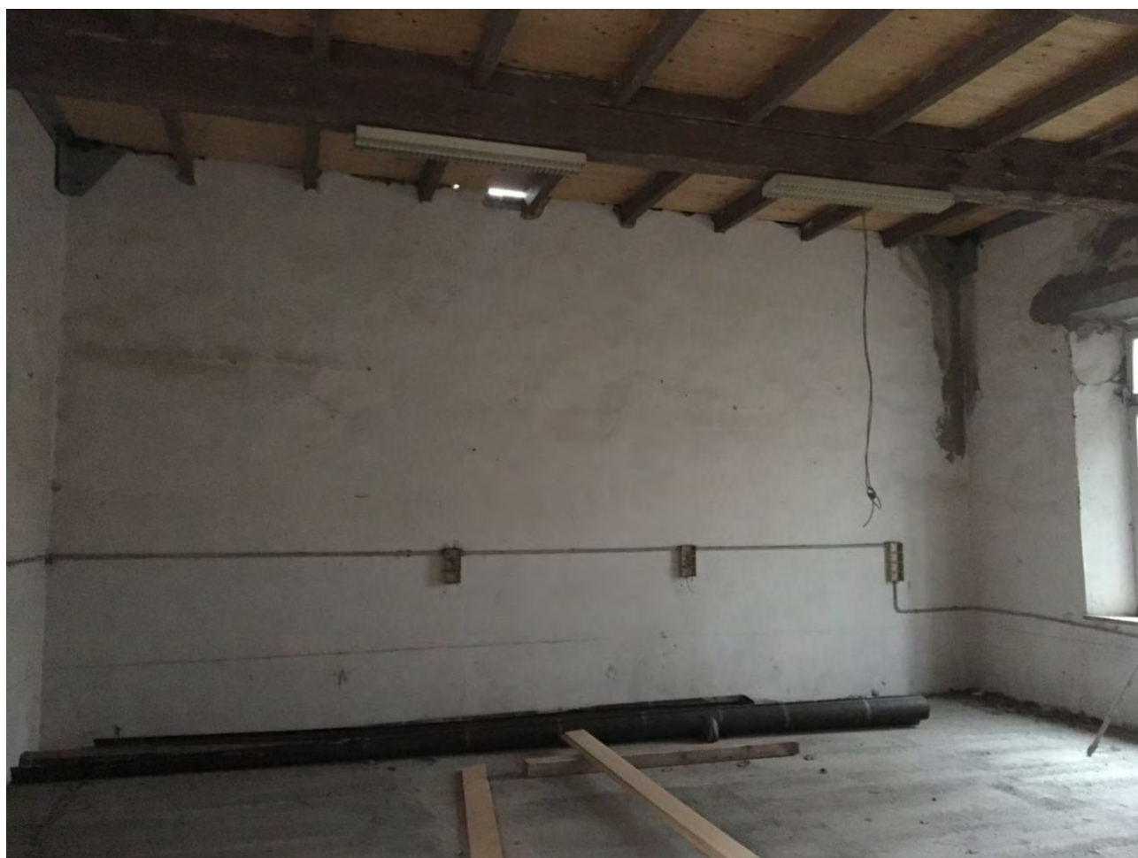
14 – vista interna del locale posto a sud-ovest: parete sud
