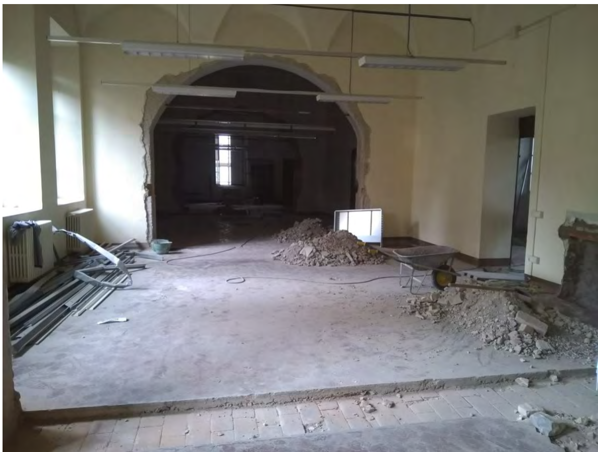
6 – infilata delle sale polifunzionali da restaurare con vista dalla sala 3 verso la sala 1. (i radiatori sono stati rimossi)
