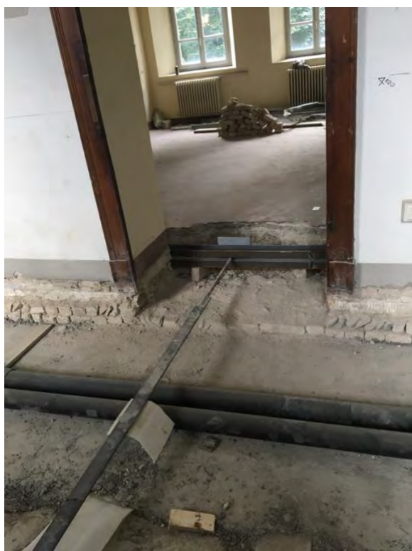
3 – Ingresso ad una sala visto dal corridoio In fase di restauro
