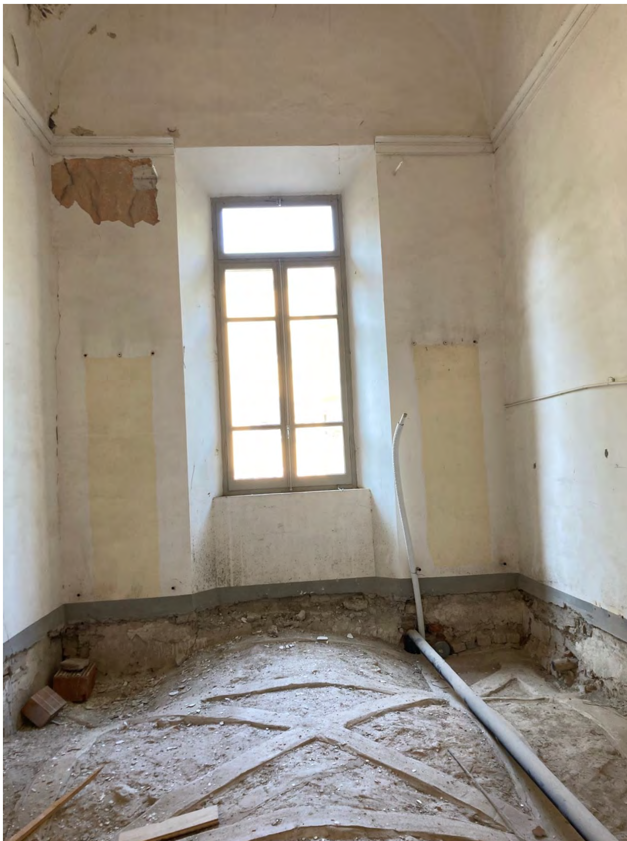
9 – Locale destinato ai bagni vista verso la finestra dove si può vedere la posizione degli scarichi predisposti e il consolidamento a vista delle volte
