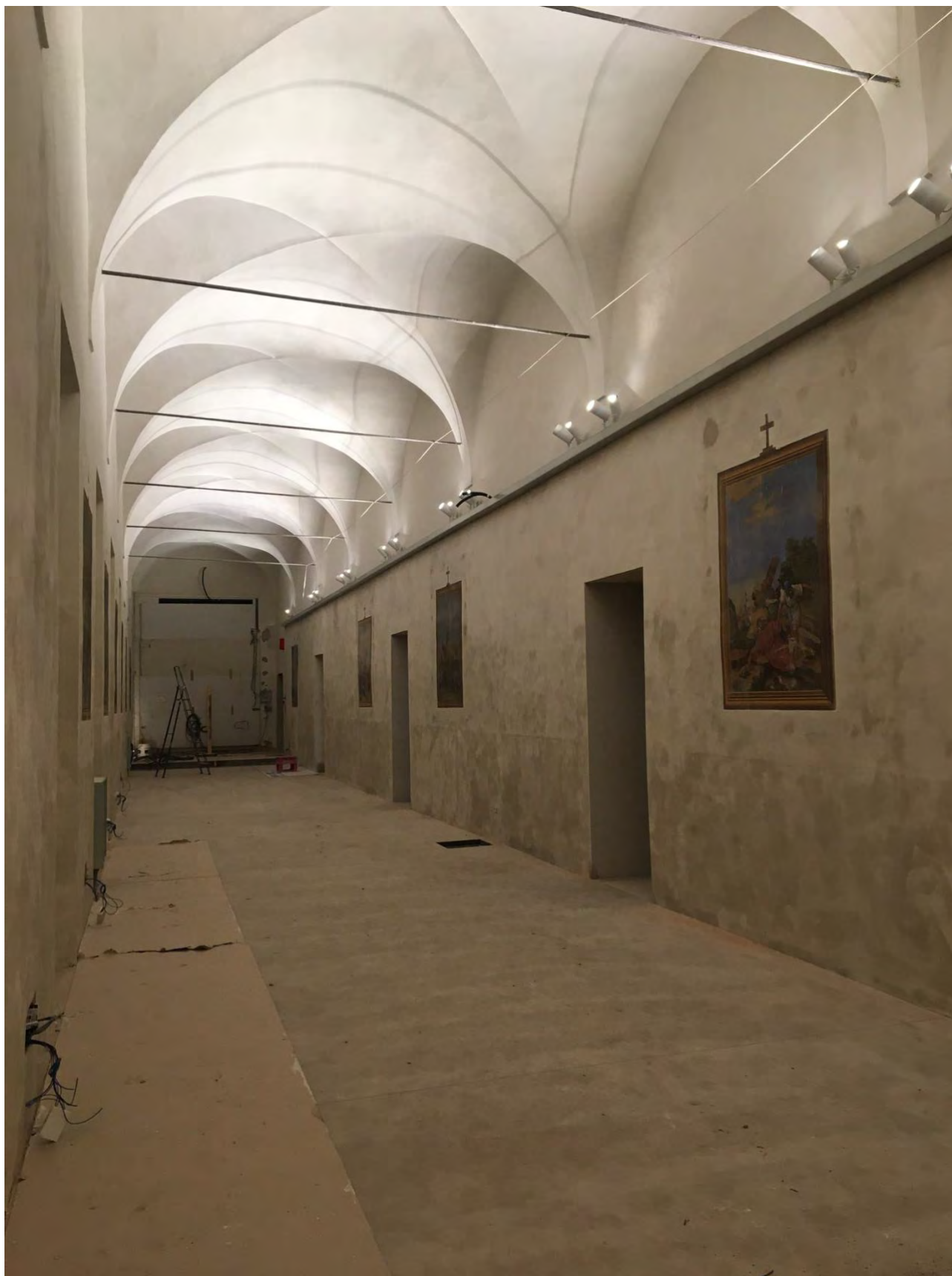
1 - Corridoio di accesso alle sale polifunzionali in completamento e con l'illuminazione.
