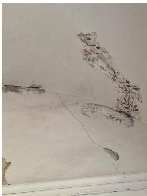
16 – 17 – Locale destinato ai bagni dettaglio dei saggi effettuati sulle volte e sulla parete sud Rilievo fotografico
