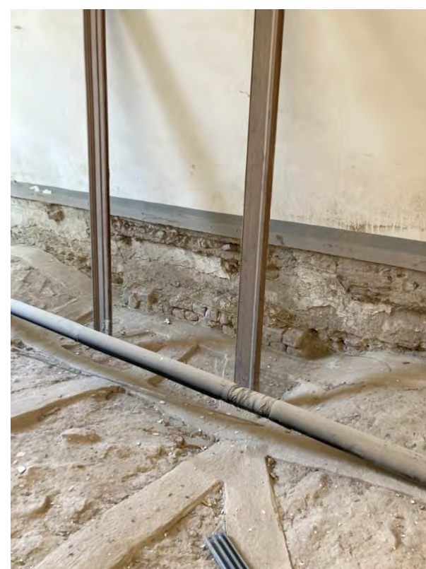
13 – 14 – Locale destinato ai bagni dettaglio del perimetro della stanza tra le volte e il futuro pavimento
