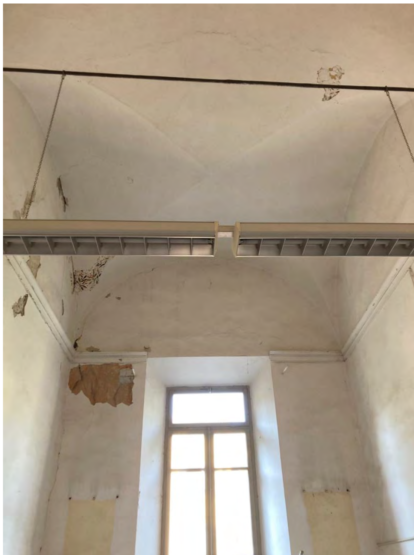
15 – Locale destinato ai bagni dove si vedono i saggi effettuati
