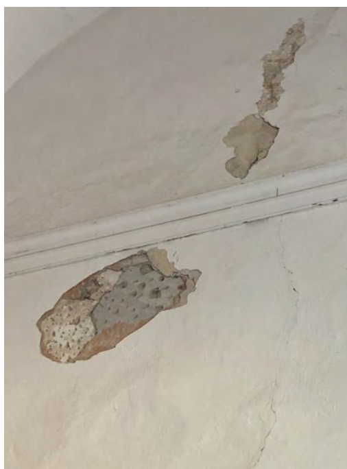
16 – 17 – Locale destinato ai bagni dettaglio dei saggi effettuati sulle volte e sulla parete sud Rilievo fotografico
