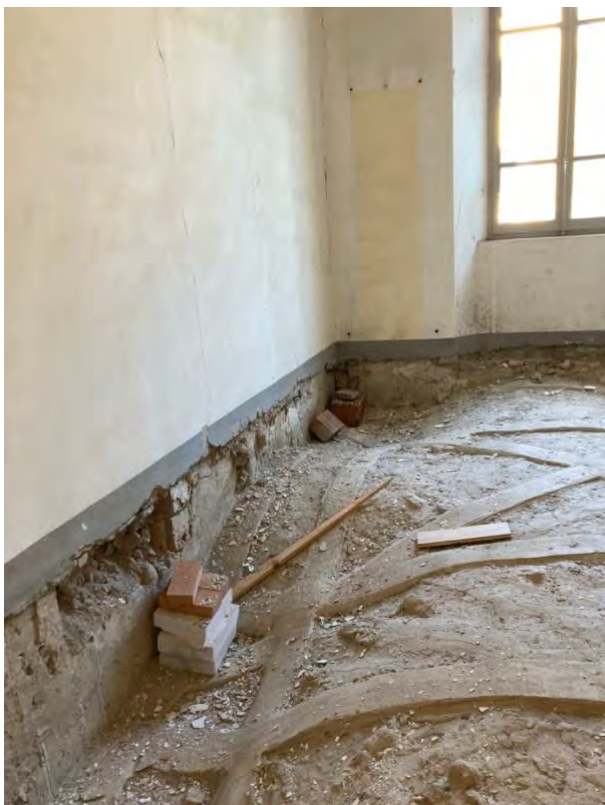
13 – 14 – Locale destinato ai bagni dettaglio del perimetro della stanza tra le volte e il futuro pavimento
