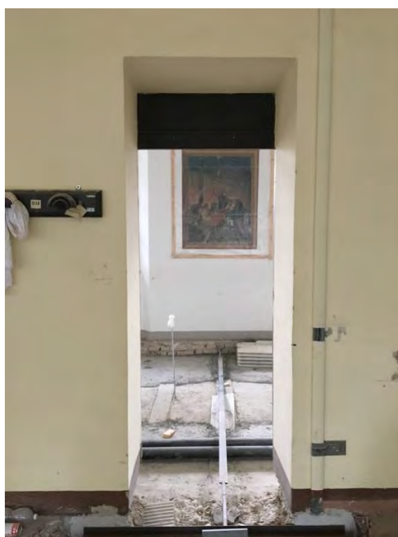
4 – Uscita da una sala verso il corridoio In fase di restauro
