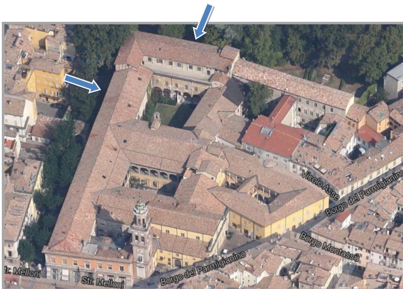
Figura 8 - Vista d'insieme da sud del Convento di San Paolo: la zona d'intervento è indicata dalla frecce, rappresentata da porzione Ovest del piano primo e piano secondo ala N-O
