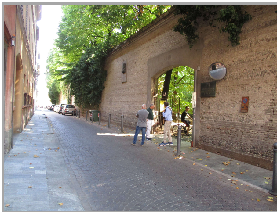
Figura 11 – l'ingresso più ad ovest dei giardini su Borgo Giordani, larghezza 3.50 m, altezza minima 3.10 m, altezza in chiave 3.40 m – CIVICO 5 BORGO GIORDANI
