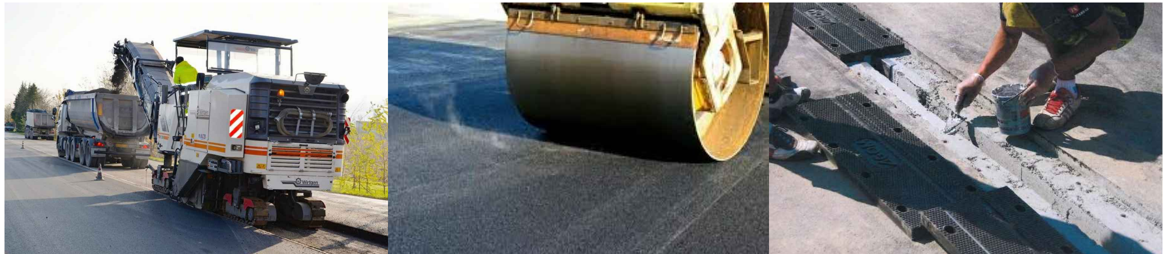
Immagini illustrative delle Fasi operative di cantiere
