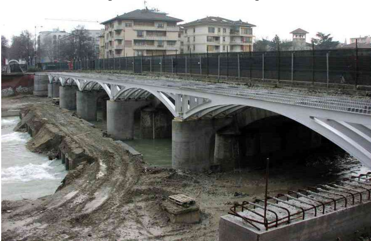
Figura 6 - Realizzazione della struttura in affiancamento sul lato di valle (2006). si nota la presenza di un guado temporaneo per una migliore gestione della movimentazione dei mezzi di cantiere
