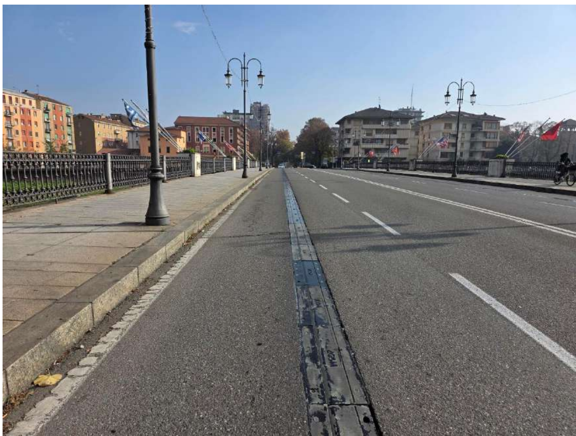
Figura 11 – Giunto lato NORD, oggetto dell'appalto
