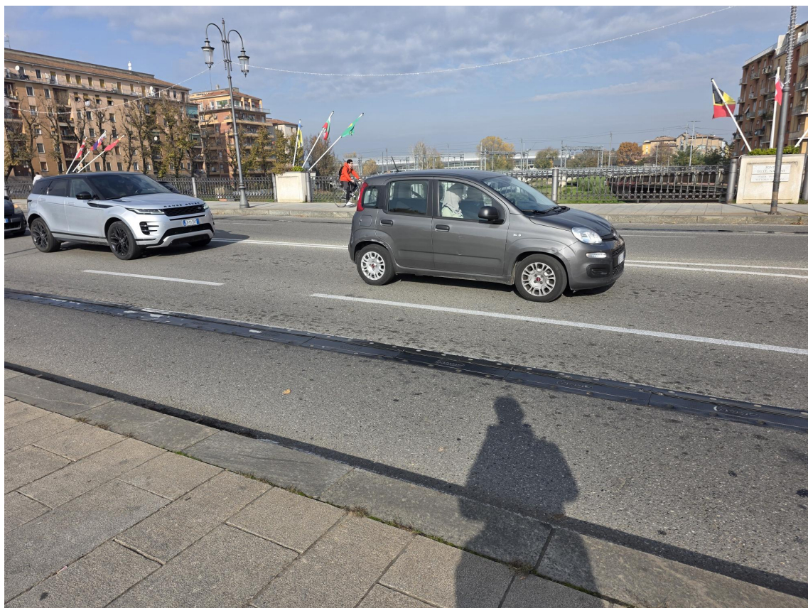
Fig. 3. Giunto lato SUD, non oggetto dell'appalto
