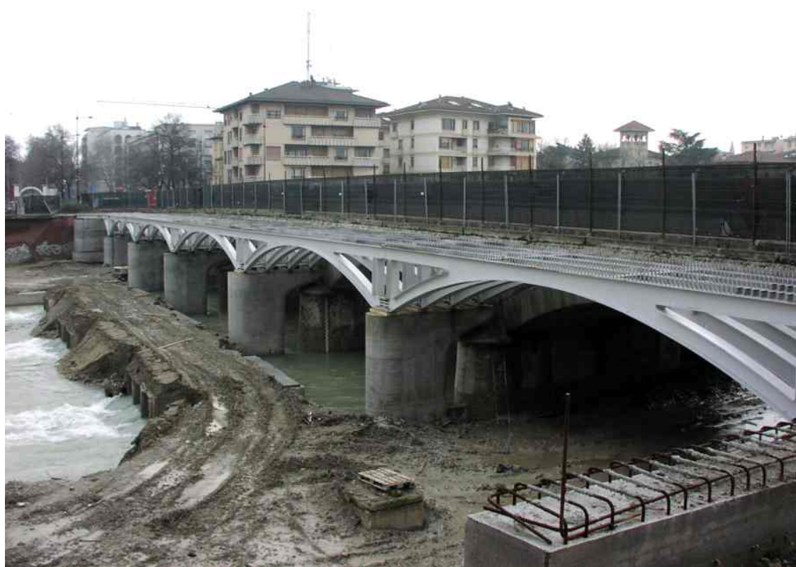
Fig. 10. Fase di cantiere durante la realizzazione dell'allargamento lato SUD
