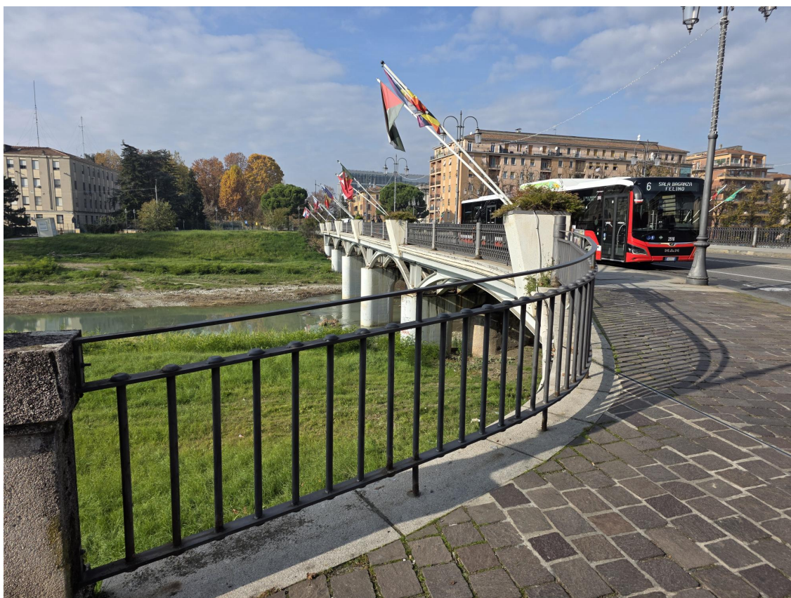
Fig. 2 – accesso al ponte da viale IV Novembre
