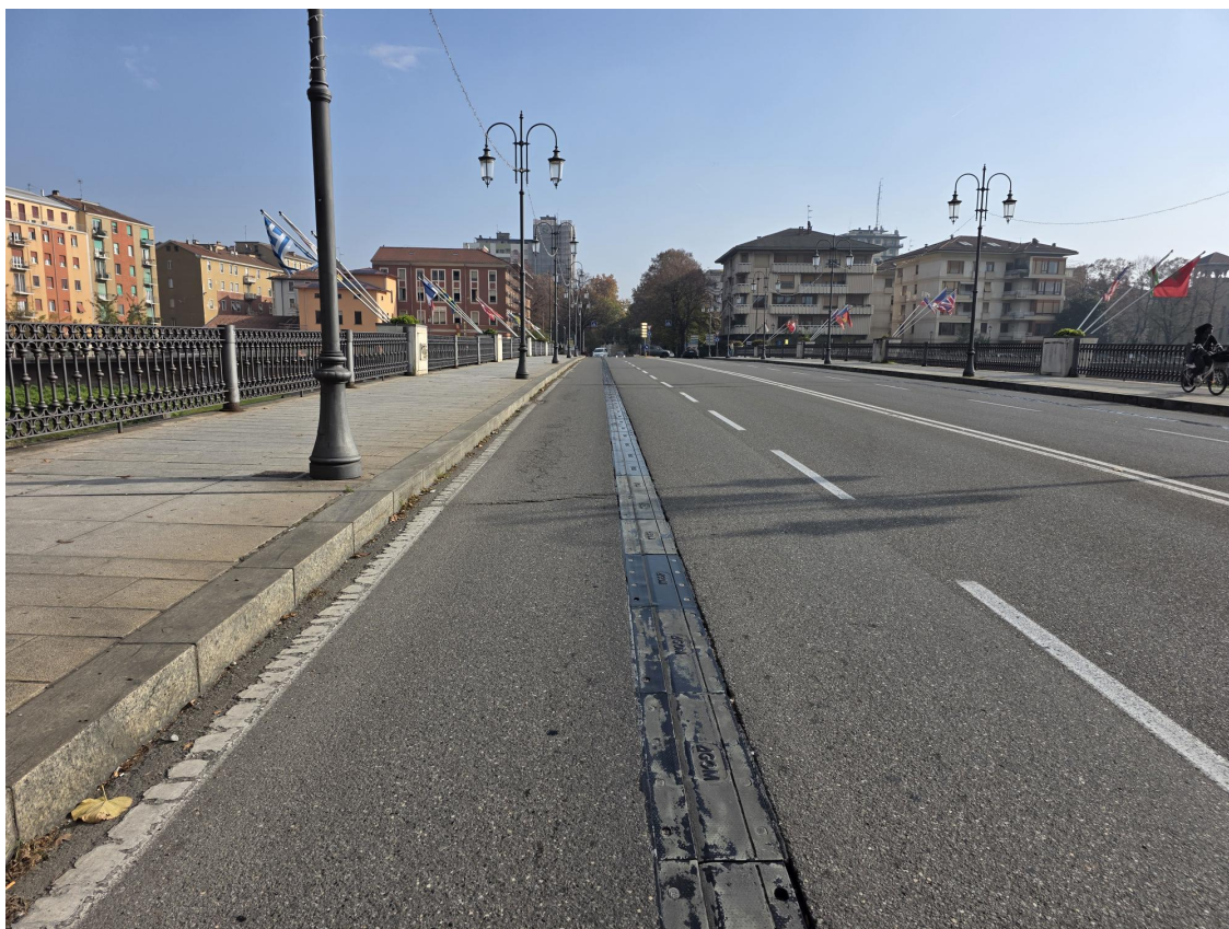
Fig. 9. Giunto lato NORD, oggetto dell'appalto
