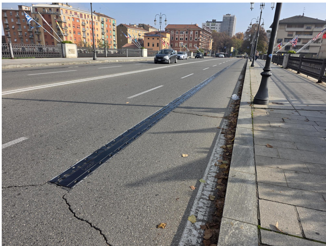
Fig. 4. Giunto lato SUD, parte terminale verso viale Piacenza
