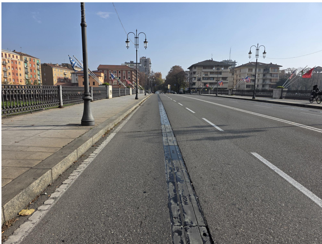
Fig. 6. Giunto lato nord, le parti grige sono i residui di materiale bicomponente testato per aumentare l'antiskid
