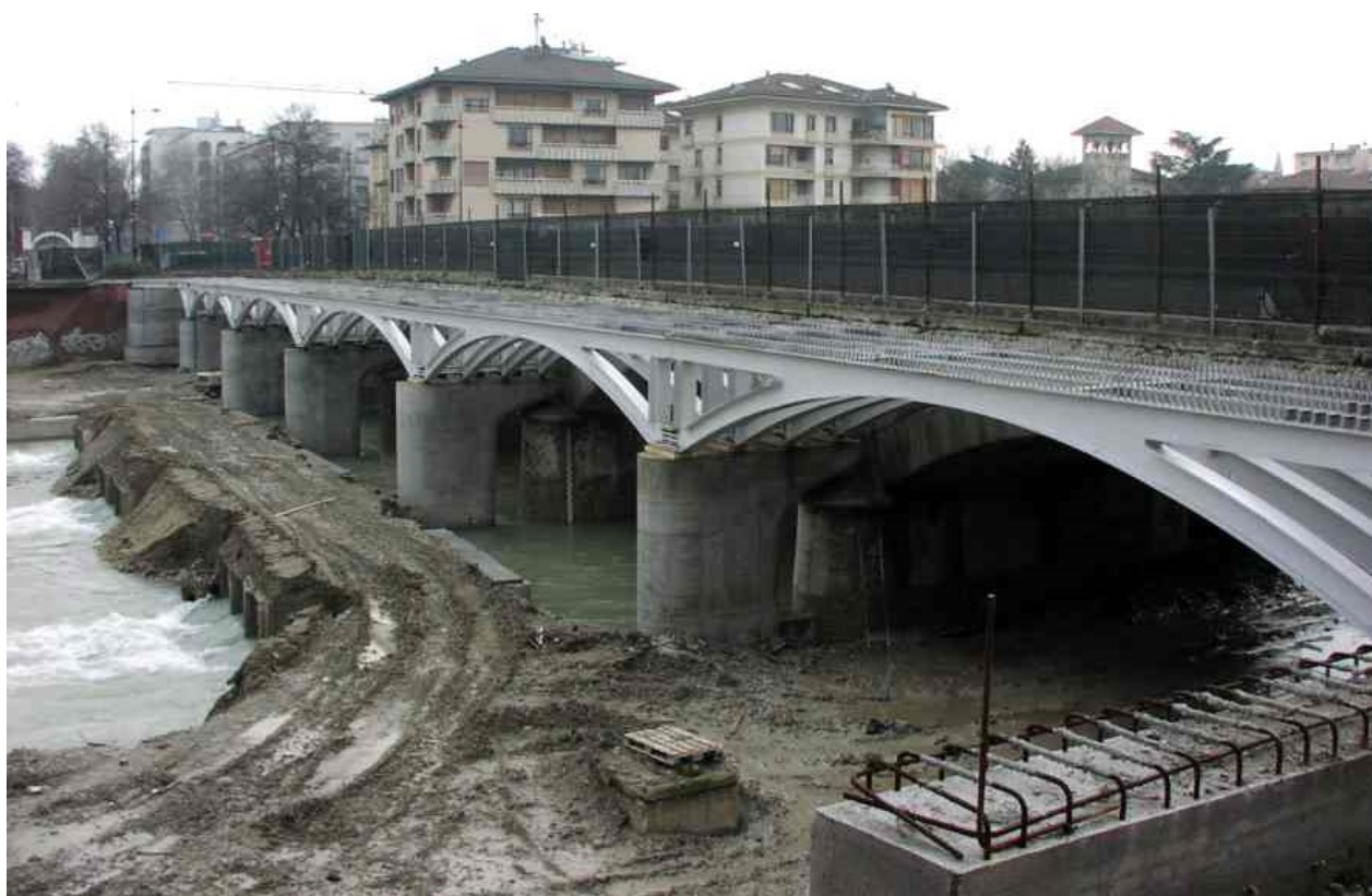
REALIZZAZIONE DELLA STRUTTURA IN AFFIANCAMENTO SUL LATO DI VALLE (2006). SI NOTA LA PRESENZA DI UN GUADO TEMPORANEO PER UNA MIGLIORE GESTIONE DELLA MOVIMENTAZIONE DEI MEZZI DI CANTIERE
