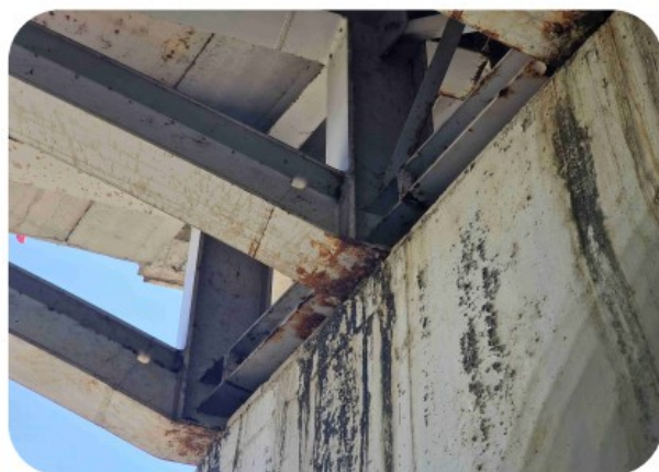
FOTO DI ALCUNE DIFETTOSITA' RISCONTRATE SULLE STRUTTURE IN ALLARGAMENTO. NONOSTANTE LA RECENTE REALIZZAZIONE DELLE OPERE SI RISCONTRANO STATI DI DEGRADO DUVUTI ALL'AZIONE DELL'ACQUA MOLTO EVIDENTI
