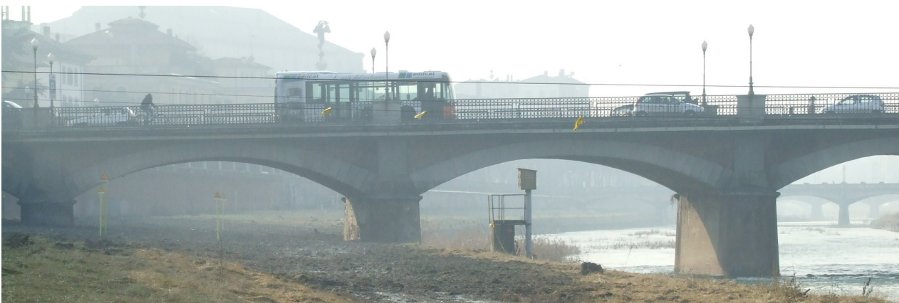
FOTO DEI PROSPETTI DEL PONTE ALL'INIZIO DEGLI ANNI 2000
