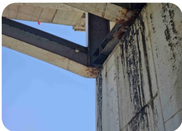
FOTO DI ALCUNE DIFETTOSITA' RISCONTRATE SULLE STRUTTURE IN ALLARGAMENTO. NONOSTANTE LA RECENTE REALIZZAZIONE DELLE OPERE SI RISCONTRANO STATI DI DEGRADO DUVUTI ALL'AZIONE DELL'ACQUA MOLTO EVIDENTI
