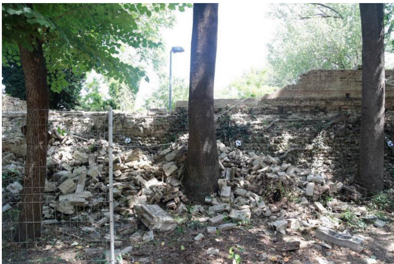
11. Attuale stato di conservazione del muro lato sud
