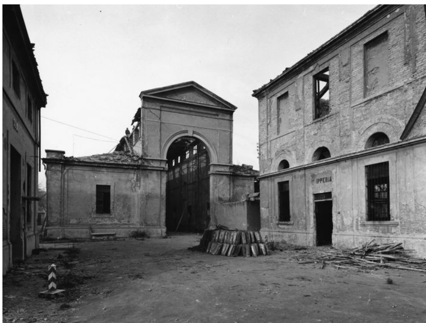
Foto n.1 – I fabbricati del Macello
