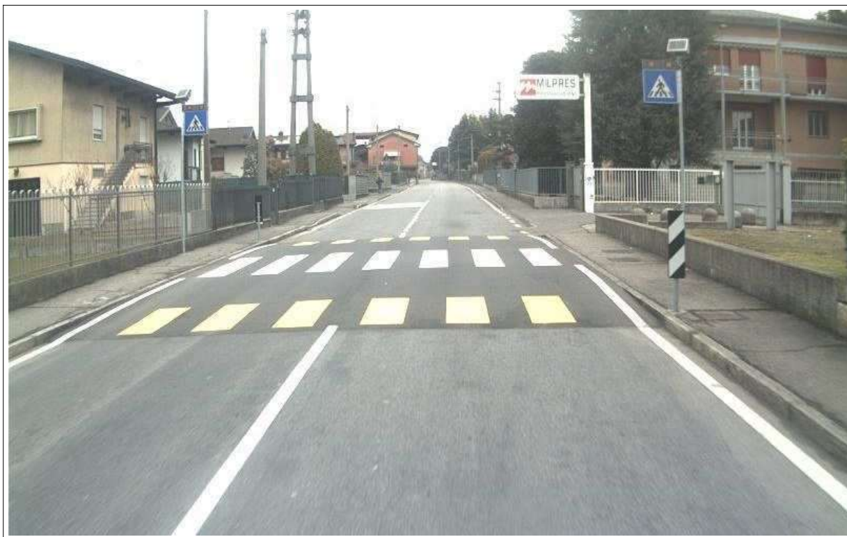
Esempio di attraversamento pedonale rialzato
