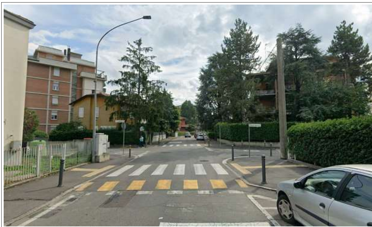
Esempio di piazza traversante rialzata
