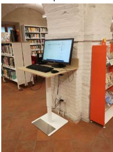
Postazione difficilmente fruibile, alta (> cm 80) e priva di possibilità di accostamento (tavolo con supporto centrale < cm 50 dal bordo)
